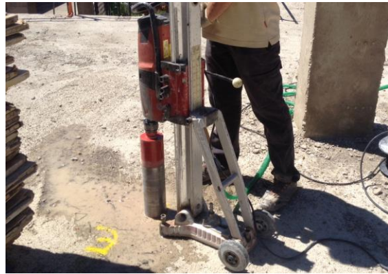
Fig. 1: Extracción probeta testigo de hormigón
