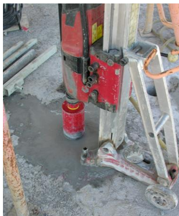
Fig. 8: Extracción de probeta testigo de hormigón
