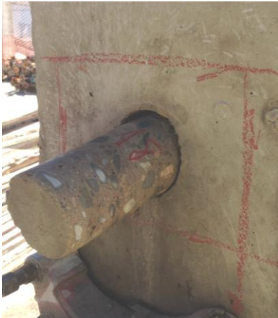
Fig. 11: Testigo de hormigón de 75 mm de diámetro en pilar
