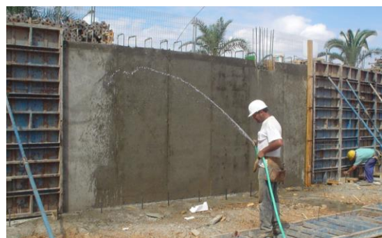
Fig. 7: Curado del hormigón en obra
