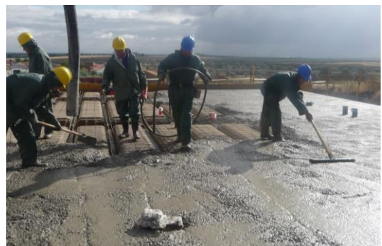
Fig. 5: Vertido y compactado del hormigón en obra
