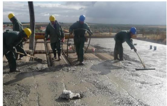
Fig. 5: Vertido y compactado del hormigón en obra
