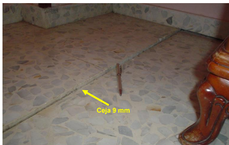
Fig. 11. Lesiones en solado por deformaciones diferenciales o excesivas de forjados
