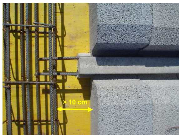
Fig. 7. Espacio para macizado entre viga-bovedilla y cegado lateral de bovedillas. CORRECTO
