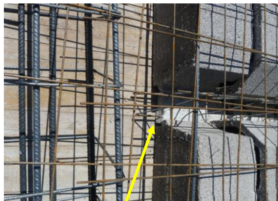
Fig. 5. Deficiente longitud de vigueta, sin conexión a la viga
