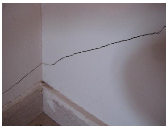
Fig. 9. Lesiones en tabiquería por deformaciones excesivas de forjados
