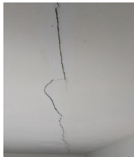
Fig. 18. Fisuración en cara inferior de forjado por cambio de rigidez de viguetas
