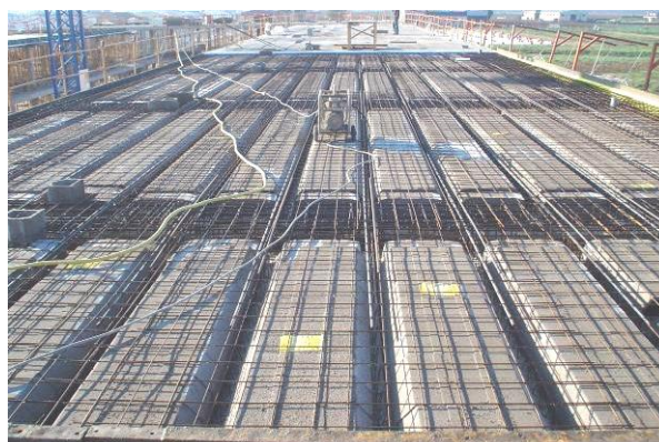
Fig. 1: Vista general forjado unidireccional
