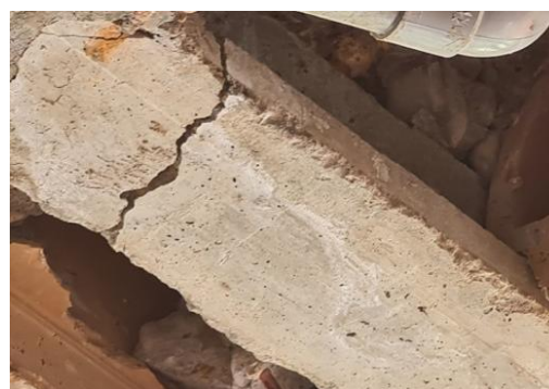
Fig. 11. Lesiones en solado por deformaciones diferenciales o excesivas de forjados
