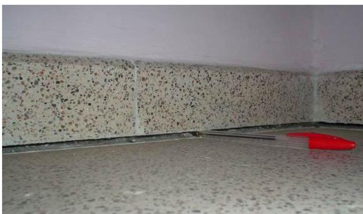
Fig. 10. Separación tabique-solado por deformaciones diferenciales o excesivas de forjado
