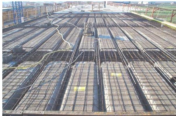
Fig. 1: Vista general forjado unidireccional
