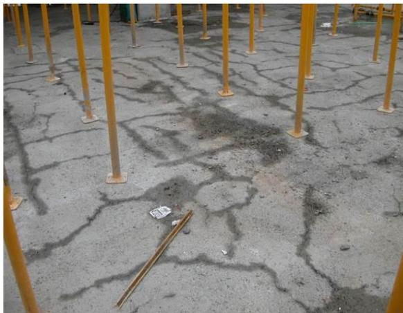
Fig. 15. Fisuración por retracción hidráulica
