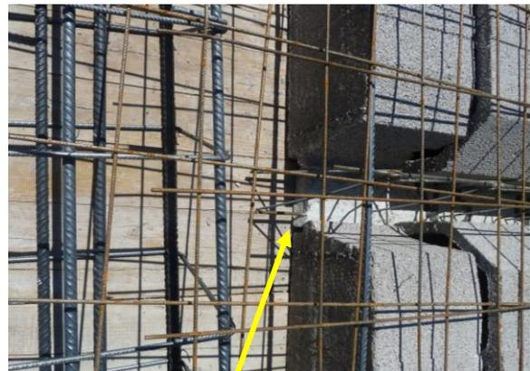
Fig.5. Deficiente longitud de vigueta, sin conexión a la viga
