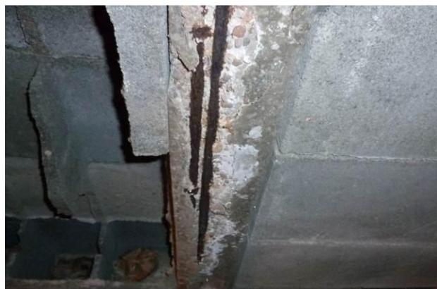
Fig. 17. Desprendimiento del hormigón de vigueta por corrosión de armaduras
