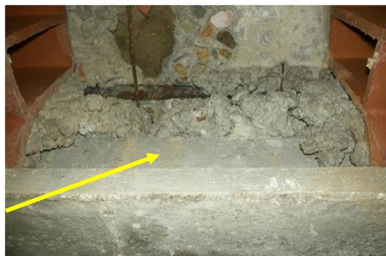
Fig. 8. Deficiente vertido y compactado del hormigón entre vigueta y bovedilla
