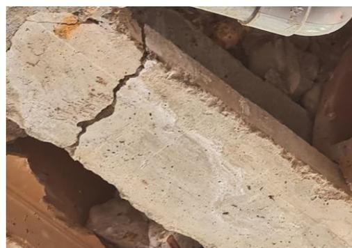
Fig. 12. Fisuración en viga por flexión y/o deformación excesiva
