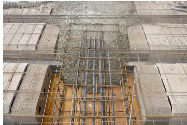
Fig. 2: Hormigonado forjado unidireccional
