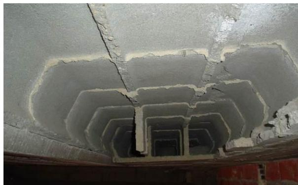
Fig. 14. Rotura y desprendimiento de bovedillas de hormigón por deformaciones diferenciales
