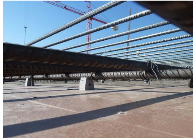
Fig. 4 Colocación separadores para garantizar el recubrimiento
