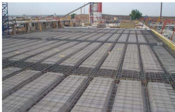
Fig. 1: Vista general de una estructura hormigón armado
