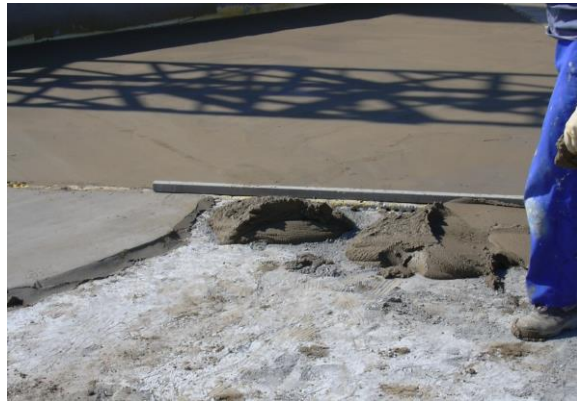
Fig. 1: Ejecución de paños de la formación de pendientes
