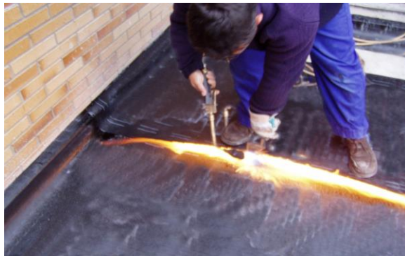
Fig. 2: Proceso de colocación de una lámina impermeabilizante
