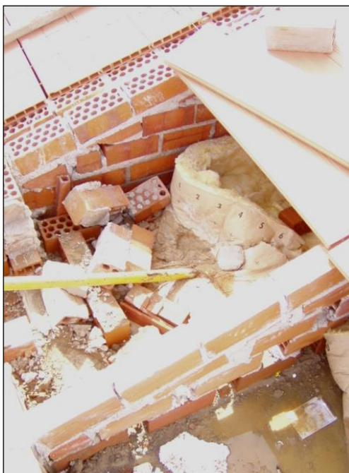
Fig. 3: Ejecución no cuidada de formación de pendiente con falta de limpieza, deterioro del aislante, colocación del papel kraft a la inversa....
