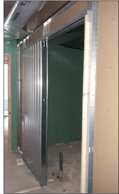
Fig. 6: Colocación de un kit de precerco metálico empotrado para una puerta corredera en una tabiquería de placa de yeso laminado. →
