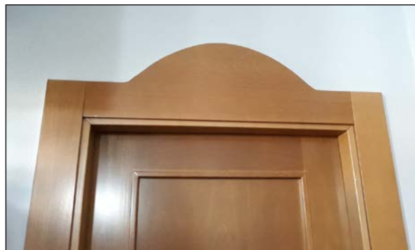
Fig. 7: Colocación de tapajuntas plano a tope. La pieza superior se le ha dotado de un sobre-ancho en semicírculo.
