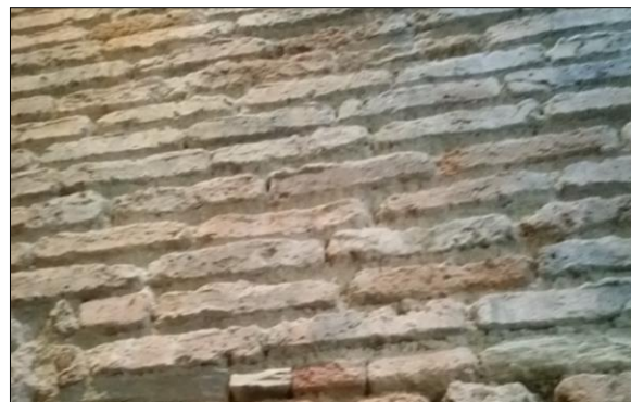
Fig. 2: Fábrica antigua con ladrillos del tejar dispuestos a soga
