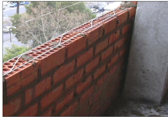
Fig. 1: Colocación de armadura de tendel en la hoja principal
