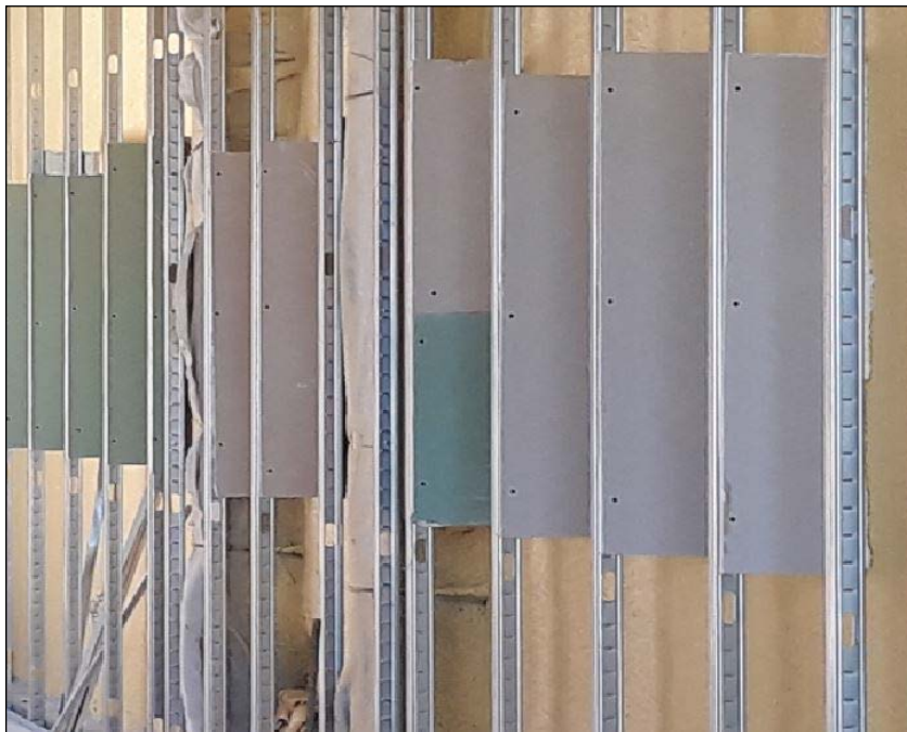
Fig. 6: Vista general de un trasdosado autoportante con la subestructura rigidizada mediante lambetas en cada montante.
