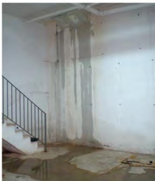
*Filtración por arranque de escalera exterior, no impermeabilizada*
