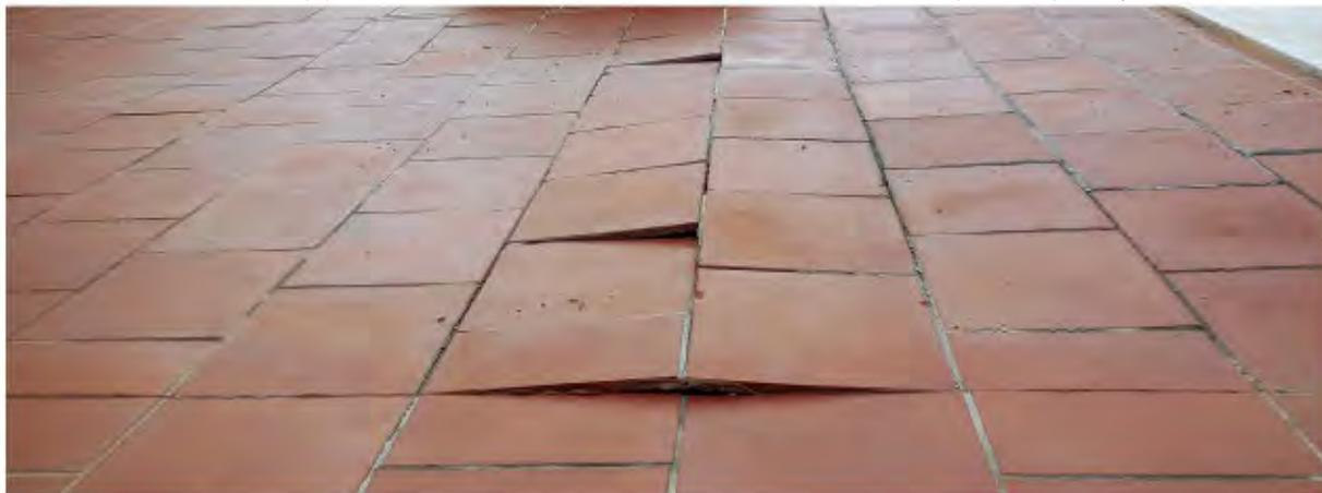
Levantamiento en "tienda de campaña" por omitir junta o por construirla deficientemente
