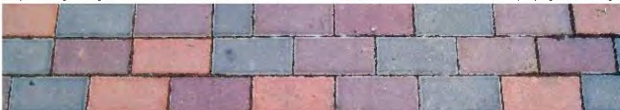
Adoquín rectangular de hormigón coloreado
