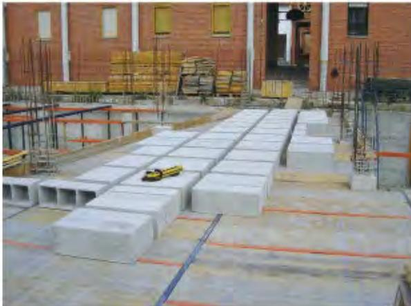
Casetones de hormigón para forjado reticular (bidireccional)
