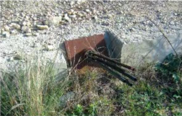
*Cabeza de anclaje de un terreno a través de elemento de hormigón*
