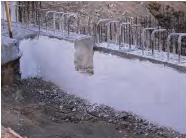
Impermeabilización **muro-sótano** con **mortero hidrófugo**
