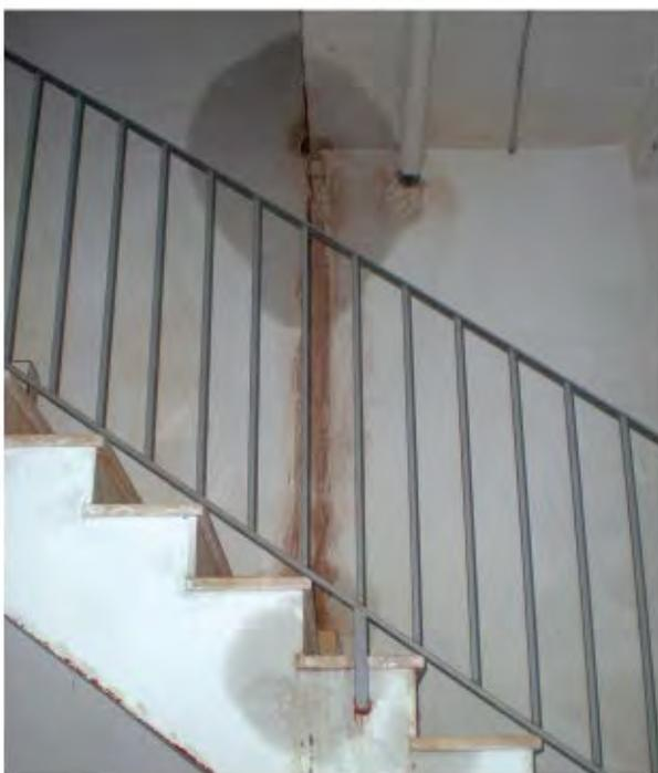
*Filtración por junta de dilatación*
