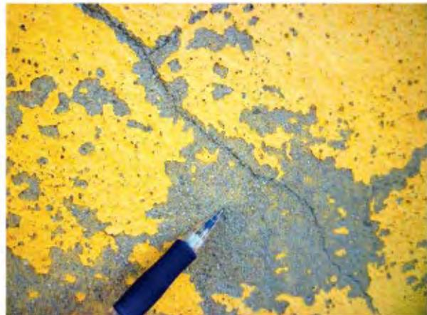
*Detalle fisura típica de retracción por afogado: superficial y de escasa abertura (arriba: efecto desertización)*
