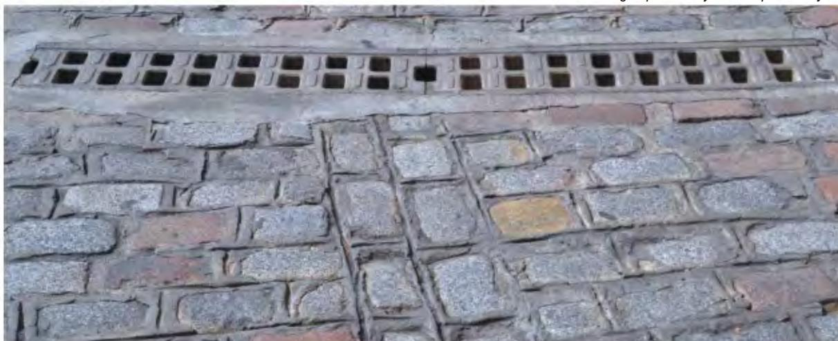
Canal – sumidero instalado en vial
