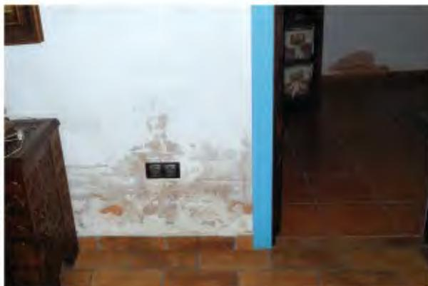
Humedad capilar en un tabique por la presencia de agua bajo la solería
