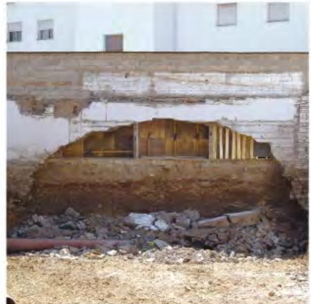
*Colapso por asiento en el centro del arco (se denomina "arco de descarga")*
