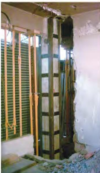
Refuerzo de **pilar** mediante empresillado
