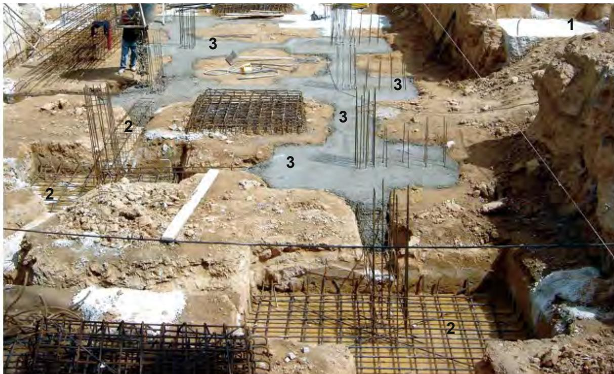
0.- Se excavan pozos para zapatas y zanjas para zunchos
