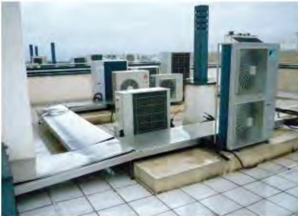
*Bancada sobre cubierta pavimentada*
