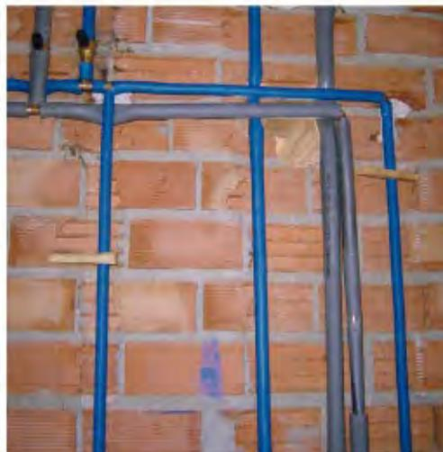
Tuberías instaladas, aisladas (gris) y protegidas (azul)
