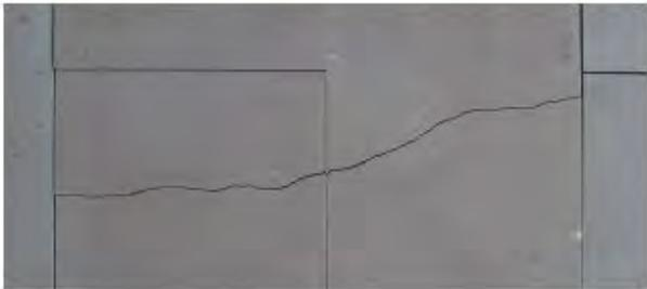
*2 placas agrietadas: cerramiento aplacado fisurado*
