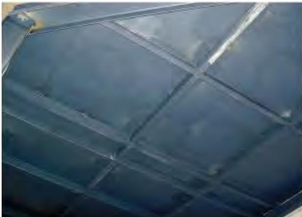
Entramado de vigas de acero de perfiles en "I"
