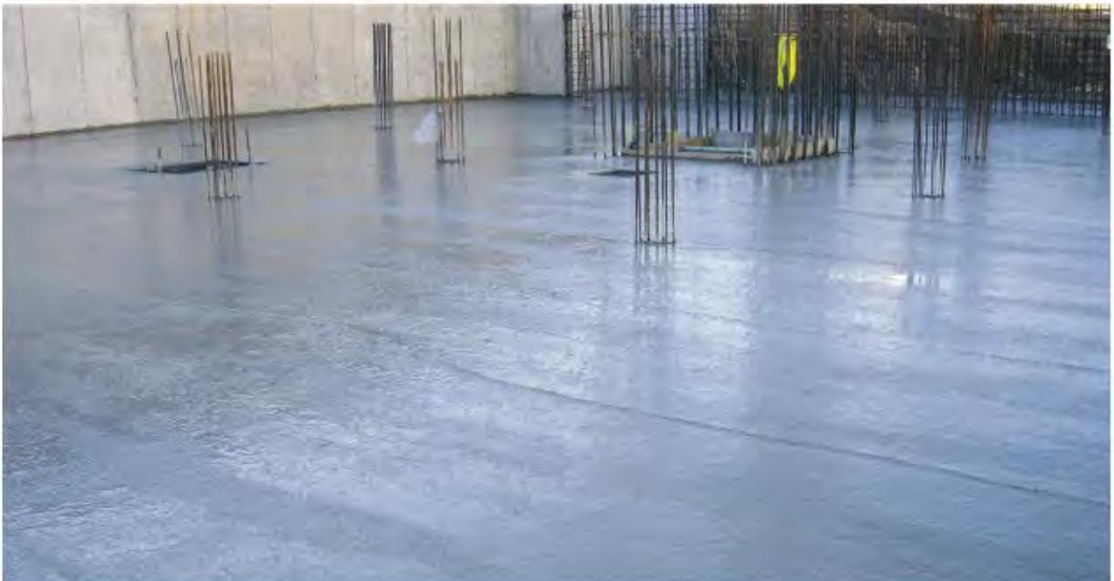
*Losa de cimentación recién hormigonada*
