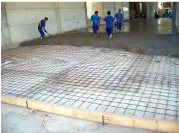
Hormigonando solera armada con mallazo
