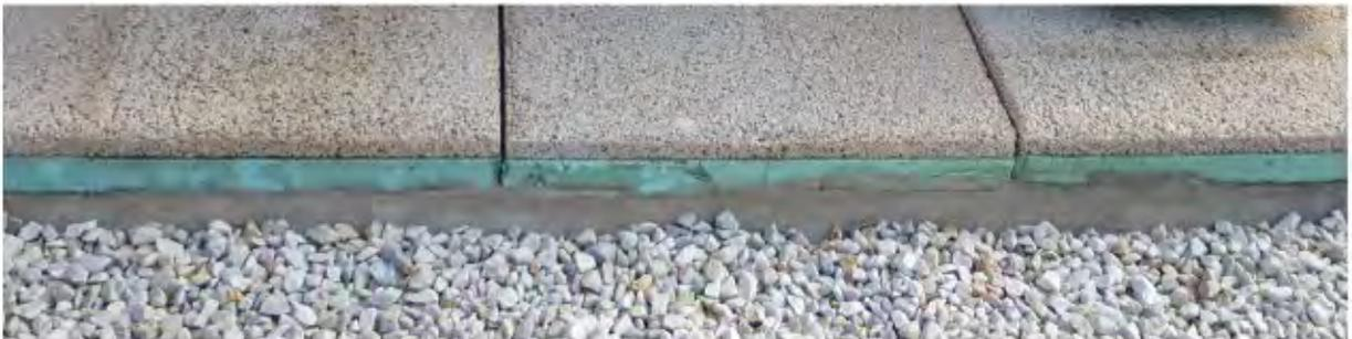
*Detalle bancada con aislante (verde). La bancada es el conjunto base de hormigón + aislante + baldosas*
