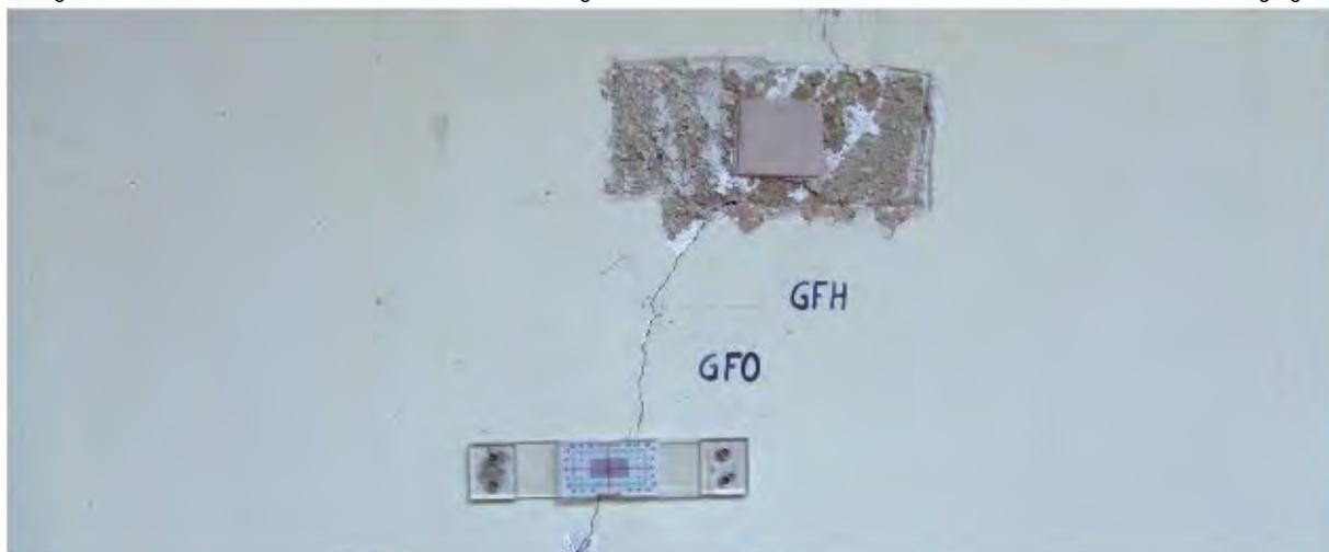
Testificación de fisura: abajo, extensímetro; arriba, testigo de yeso
