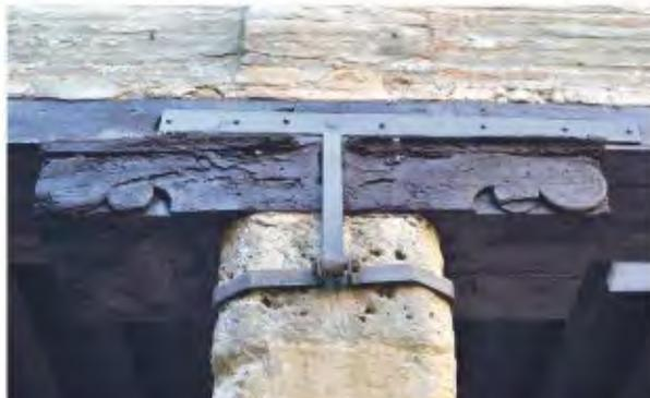
*Abrazadera en cabeza de pilar de piedra para evitar desplazamiento*
