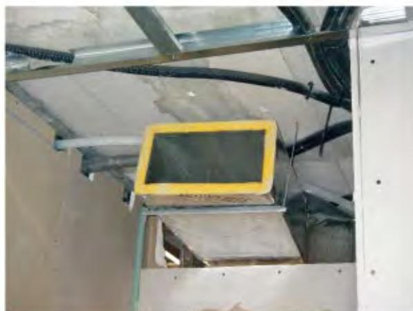
Conducto de aire acondicionado con panel termoacústico de lana de vidrio
