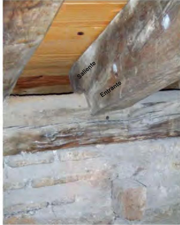
Ensamble de par con durmiente / estribo, con entalladura en el par
