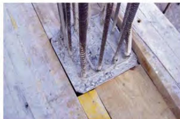
Efecto en las esquinas del pilar hormigonado, que produce la inclusión del berenjeno de la izquierda
