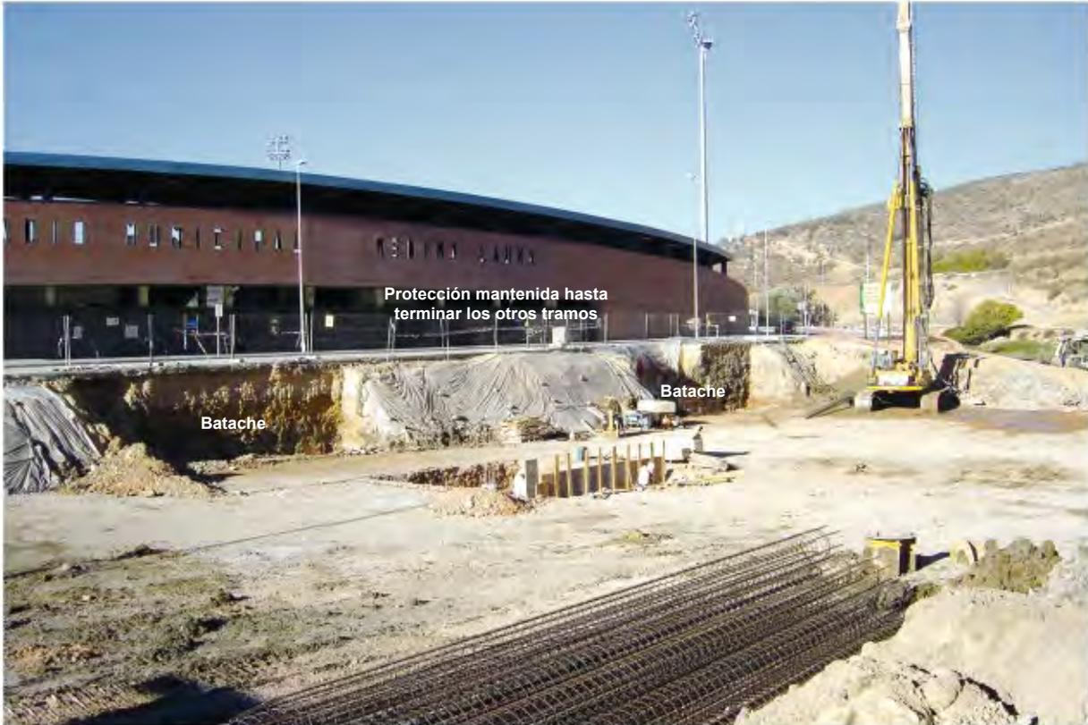
*Hasta que no se construyan los tramos de muro en los bataches abiertos, no se excavarán los tramos intermedios*
