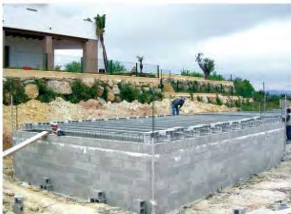
Exterior: construcción forjado sanitario de viguetas autorresistentes
