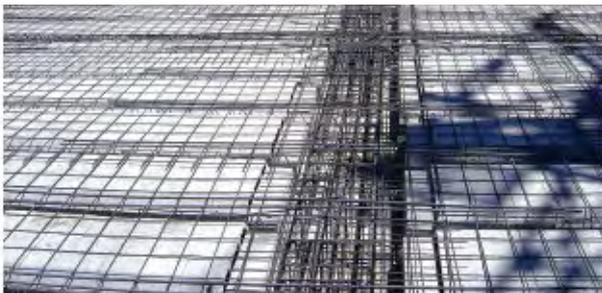
Mallazo en capa de compresión de **forjado unidireccional**
