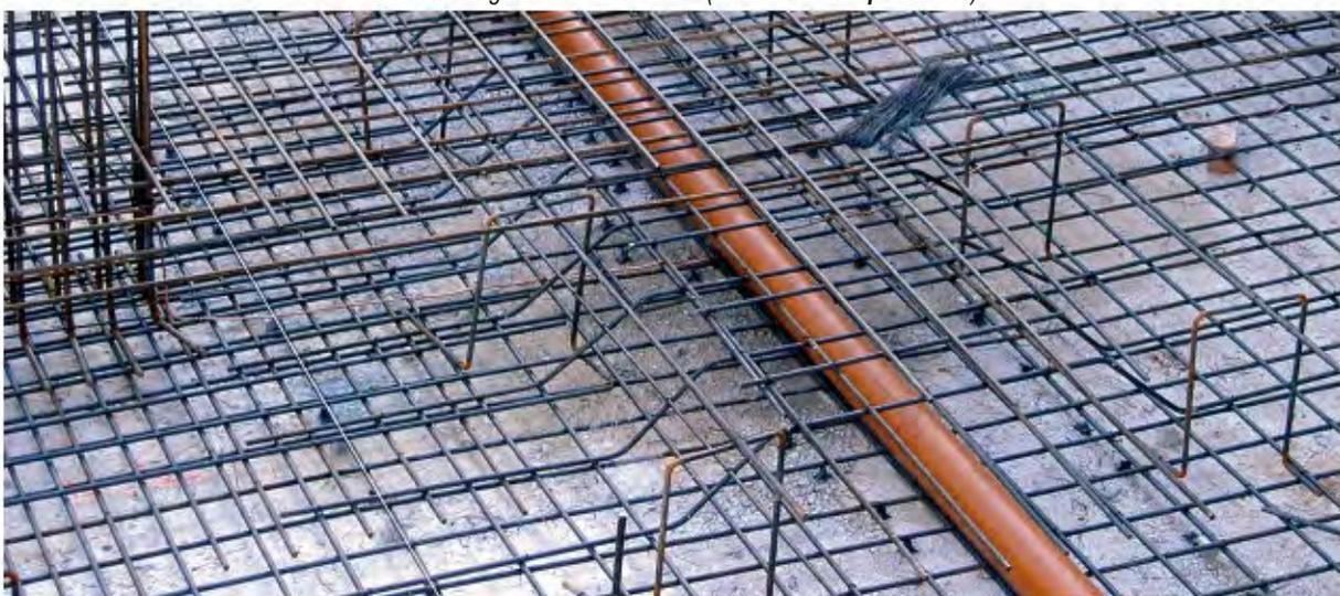
Colector empotrado ("encapsulado") en **losa** de cimentación
