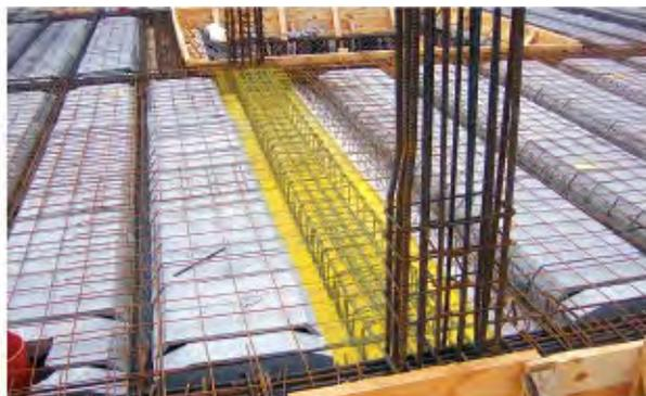
Zuncho en forjado, de pilar a pilar
