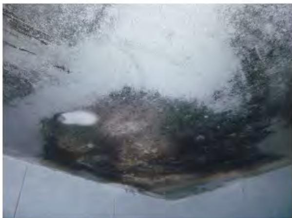
*Detalle brutal condensación en falso techo de baño*
