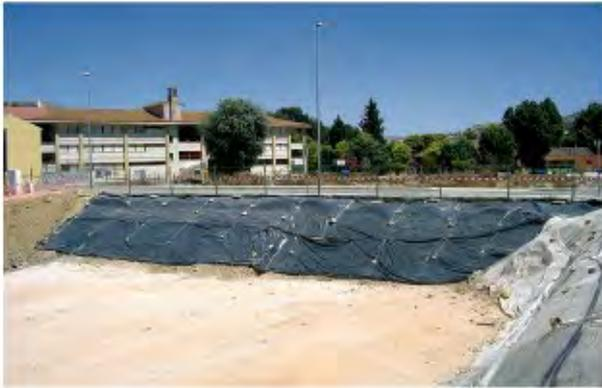
Talud protegido para evitar erosión
