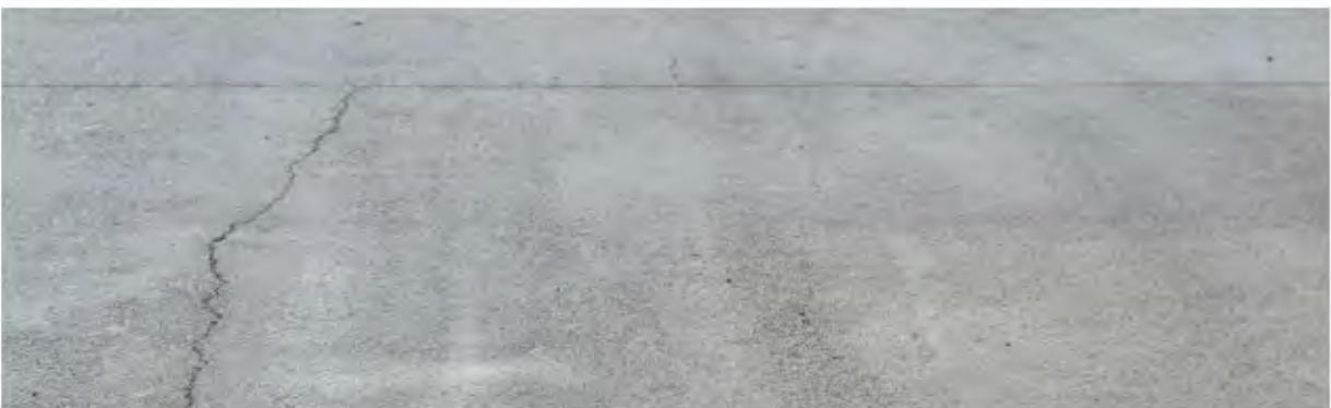
*Fisura de retracción en pavimento continuo de hormigón. La línea superior de la foto es una junta de retracción o contracción*
