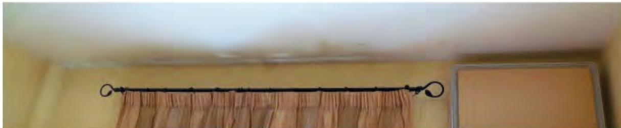
*Condensación en puente térmico unión cerramiento con techo*
