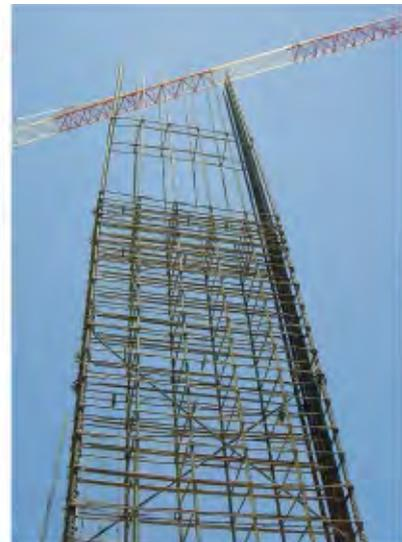
Armadura de pantalla antes de encofrar
