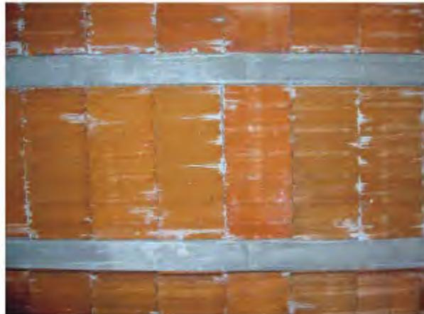
Bovedillas cerámicas en forjado unidireccional
