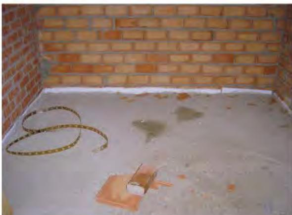
*Preparando junta perimétrica en pavimento interior*
