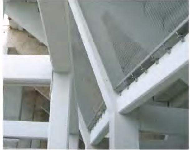
*Nudos de **hormigón**: vigas-pilares / vigas-pantallas*
