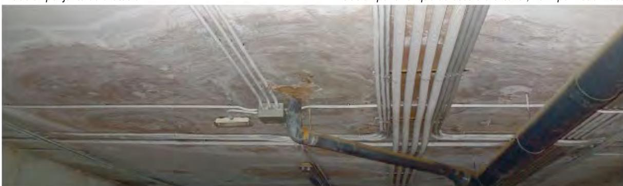
*Filtración masiva por techo de sótano*
