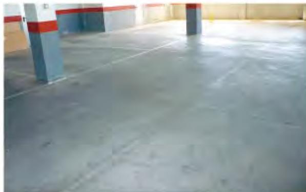
Pavimento continuo de hormigón fratasado
