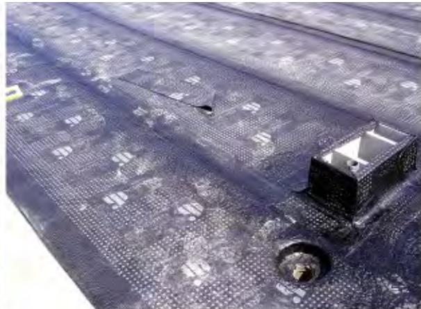
Impermeabilización **cubierta plana** con **lámina asfáltica**
