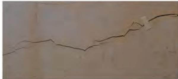
*Revestimiento agrietado / Cerramiento revestido fisurado*
