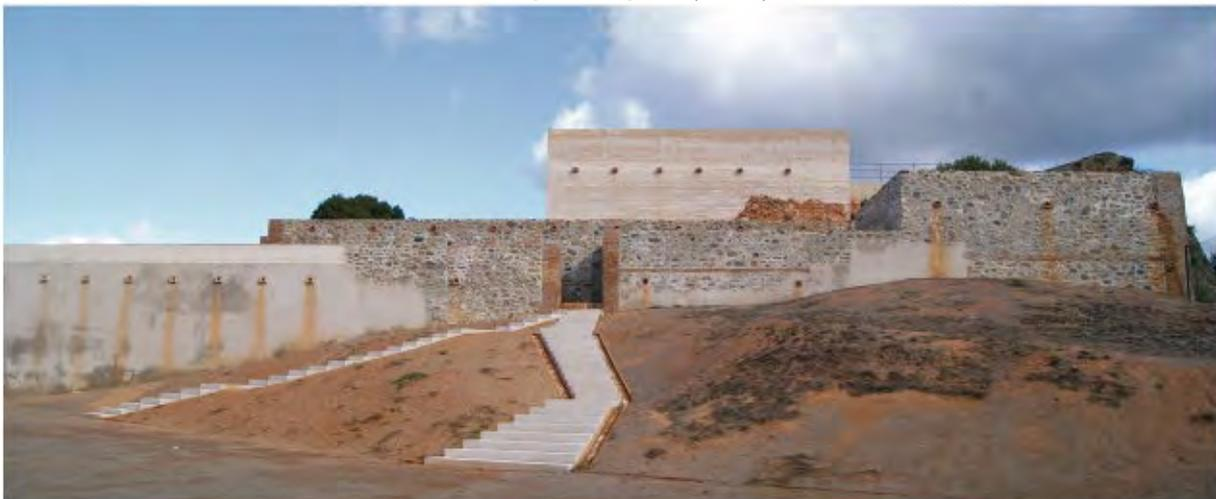
*Combinación muros de mampostería y hormigón*
