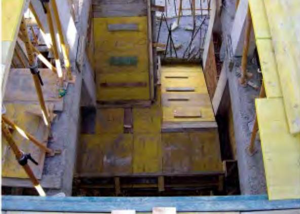
**Encofrado** de losa sin zancas
