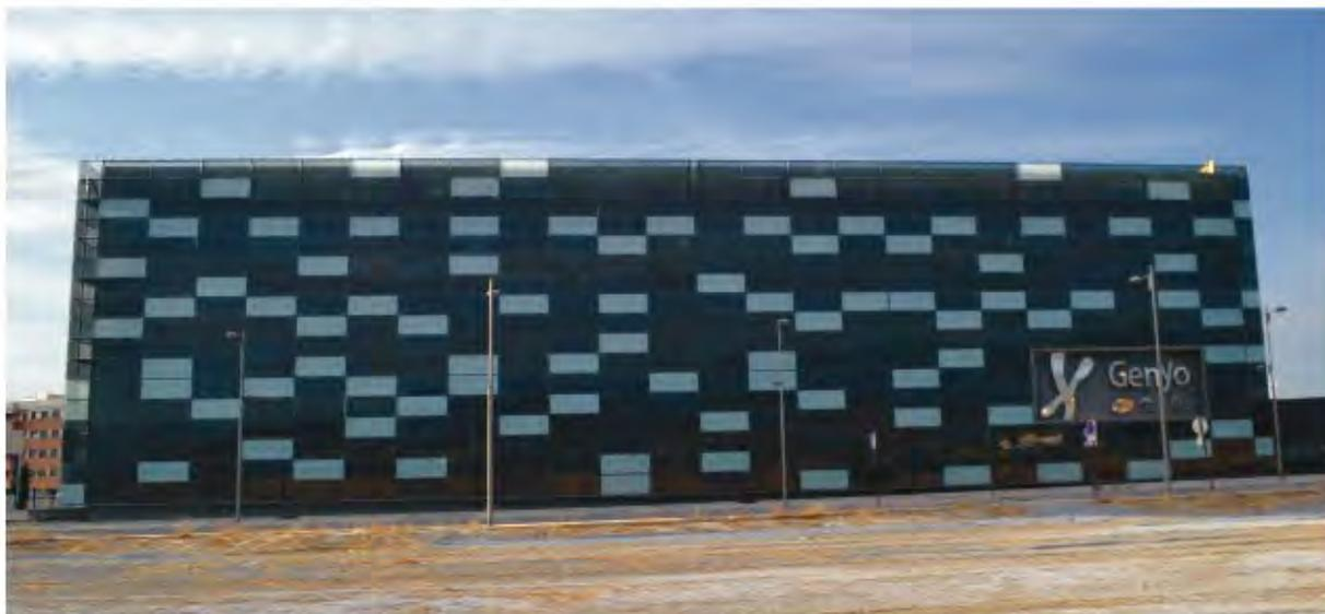
*Fachada de vidrio ventilada fotovoltaica*
