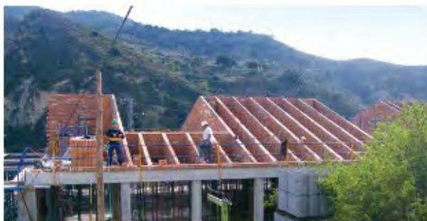
*Empalomado de ladrillo para cubierta inclinada*
