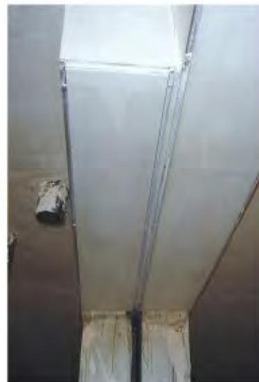
*Junta de dilatación estructural incorrecta
