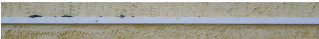
Berenjeno colocado en fase de ejecución. Aplicando el monocapa
