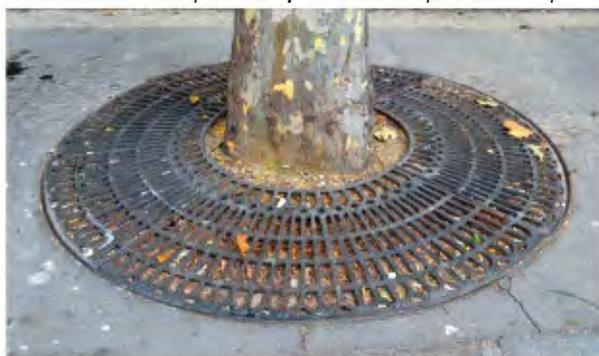
Alcorque de "fundición" (aleación hierro + carbono)
