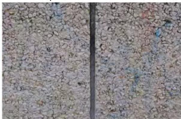
Detalle entrecalle o rehundido en mortero monocapa
