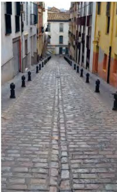
Calzada de adoquines con cuneta central
