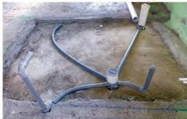
*Instalación desagües baño con bote sifónico*
