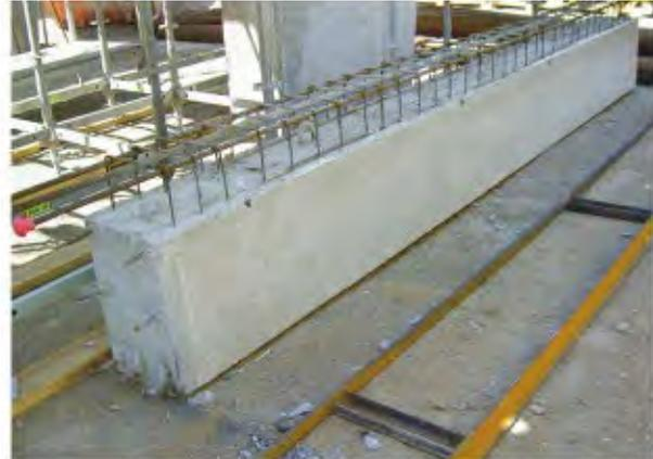
Gran viga de hormigón mixta (prefabricada sólo en el alma)
