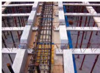
Semi-viguetas o viguetas semirresistentes
