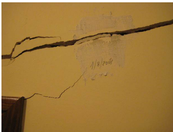
Figura 6: Cimentación en terreno expansivos: fisuras
