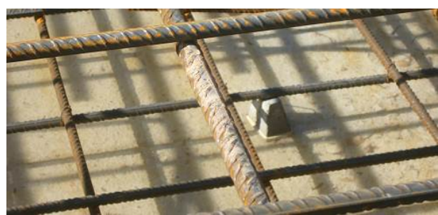
Figura 9: recubrimiento de las armaduras. Separadores
