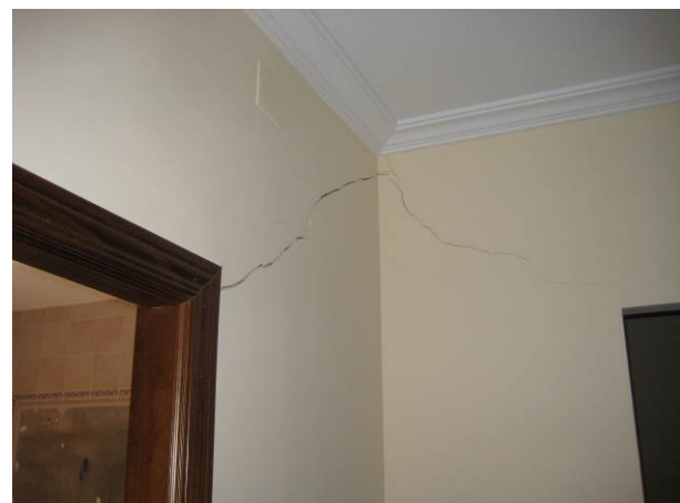
Figura 6: Cimentación en terreno expansivos: fisuras
