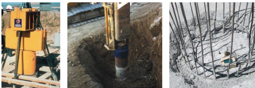
Figura 10: Ensayo de prueba de carga, ensayo dinámico de carga y control de integridad por impedancia
