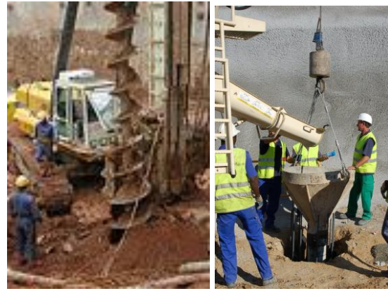
Figura 1-2: Ejecución de pilotes
