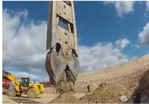
Figura 1: Excavación zanja con cuchara bivalva
