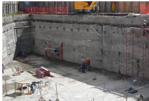
Figura 2: Muros pantalla de hormigón armado
