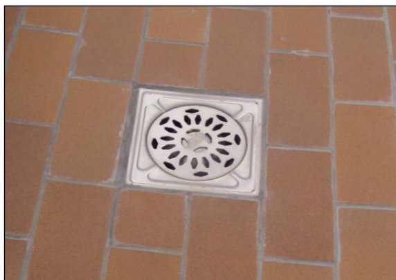
Fig. 1: Cazoleta en cubierta plana transitable
