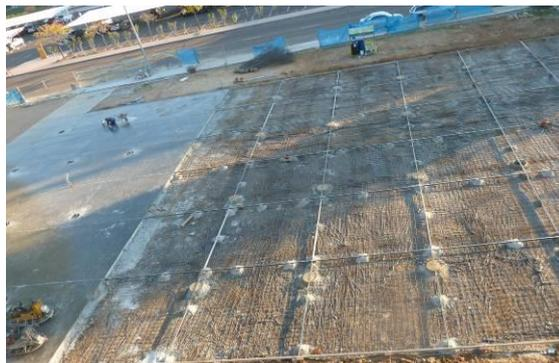
Fig. 1: Ejecución solera de hormigón
