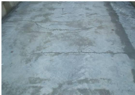
Fig. 2: Fisuraciones en solera de hormigón
