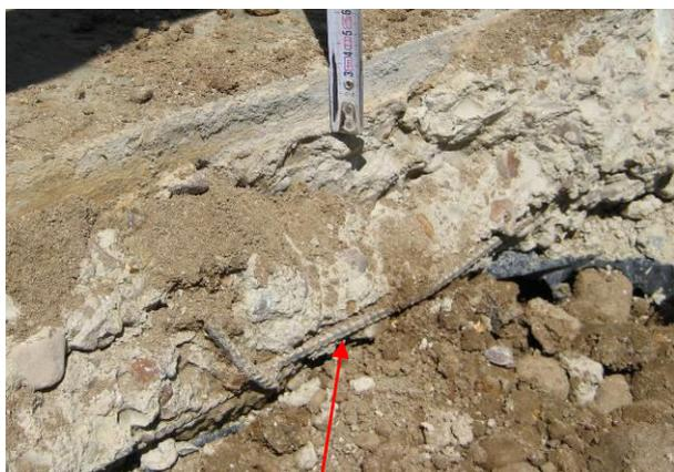
Fig. 3: Incorrecta colocación del armado.
