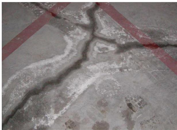
Fig. 4. Humedades de filtración por fisuras en solera
