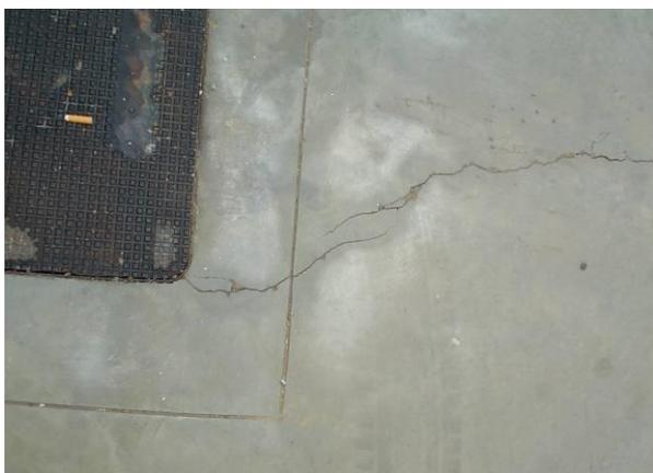
Fig. 5: Fisuración por deficiente diseño de juntas o incorrecta ejecución
