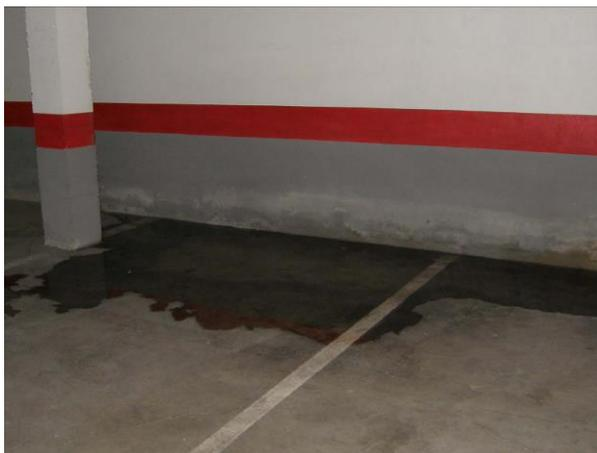
Fig. 3: Filtración por el encuentro solera-muro.
