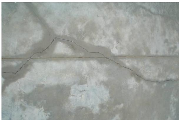
Fig. 5: Fisuraciones de retracción en solera
