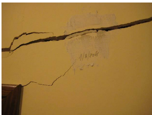
Figura 6: Cimentación en terreno expansivos: fisuras
