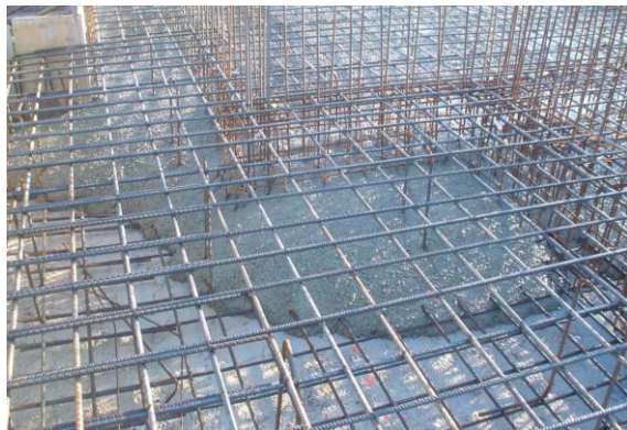
Figura 2: Hormigonado losa de cimentación
