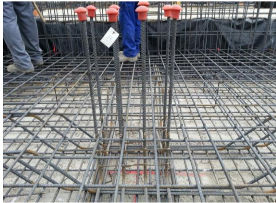
Figura 1: Ejecución de losa de cimentación
