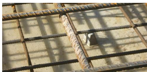
Figura 9: recubrimiento de las armaduras. Separadores
