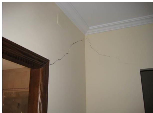
Figura 6: Cimentación en terreno expansivos: fisuras
