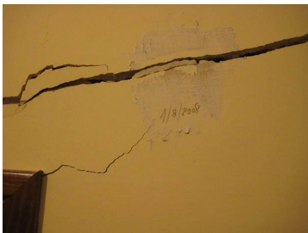
Figura 6: Cimentación en terreno expansivos: fisuras
