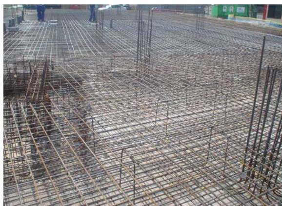
Figura 1: Ejecución de losa de cimentación
