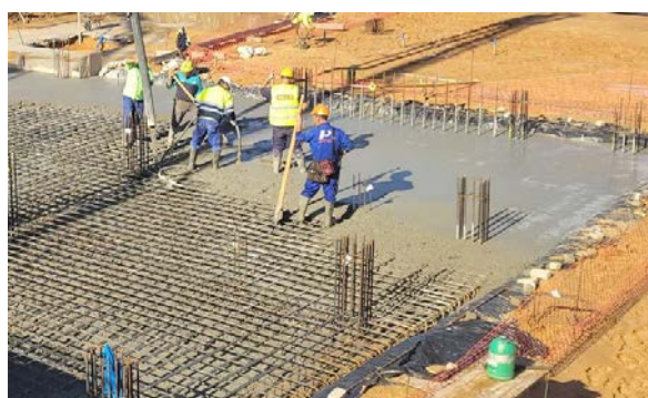
Figura 2: Hormigonado losa de cimentación
