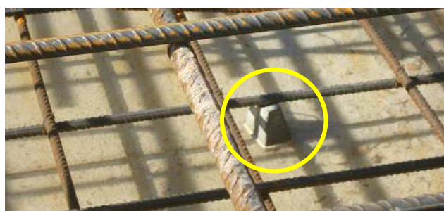
Figura 9: recubrimiento de las armaduras. Separadores
