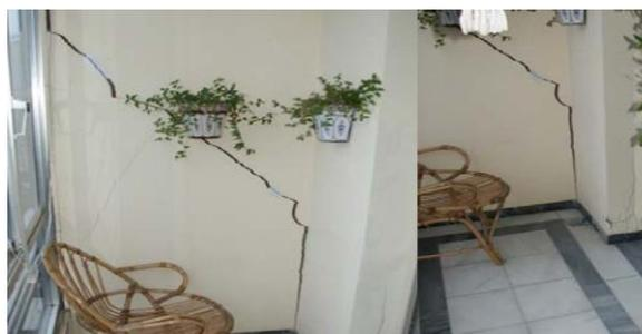
Figura 6: Invasión de cimentaciones próximas. Fisuras y/o grietas
