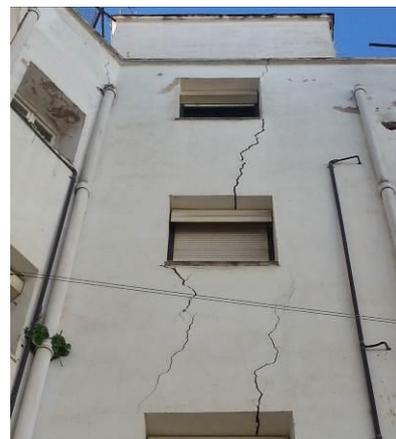
Figura 7: Fisuraciones por asentos de la cimentación
