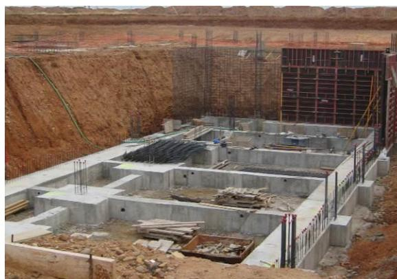
Figura 1: Ejecución de cimentación por zapatas
