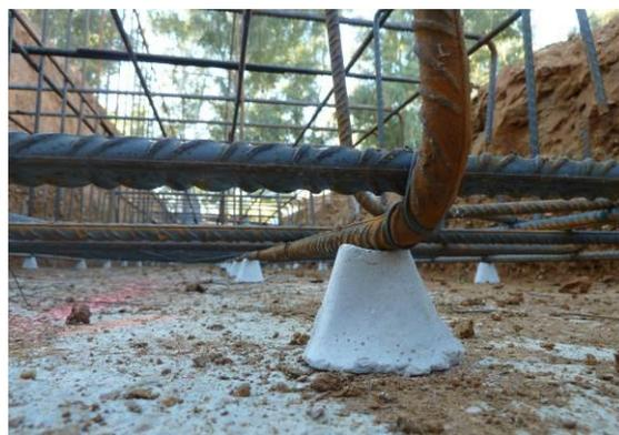
Figura 9: Recubrimiento de las armaduras. Colocación separadores
