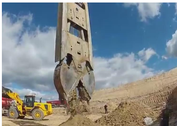
Figura 1: Excavación zanja con cuchara bivalva
