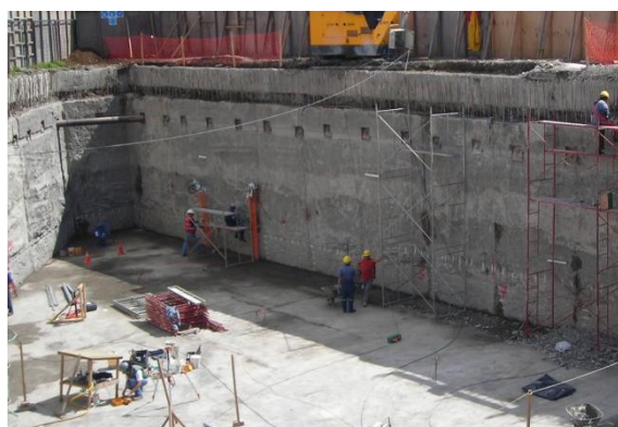
Figura 2: Muros pantalla de hormigón armado
