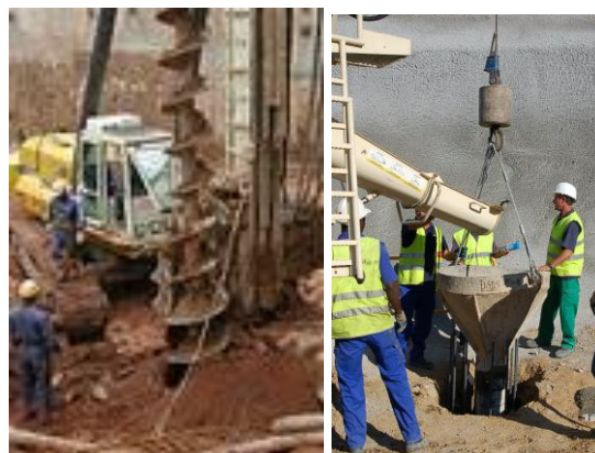
Figura 1-2: Ejecución de pilotes
