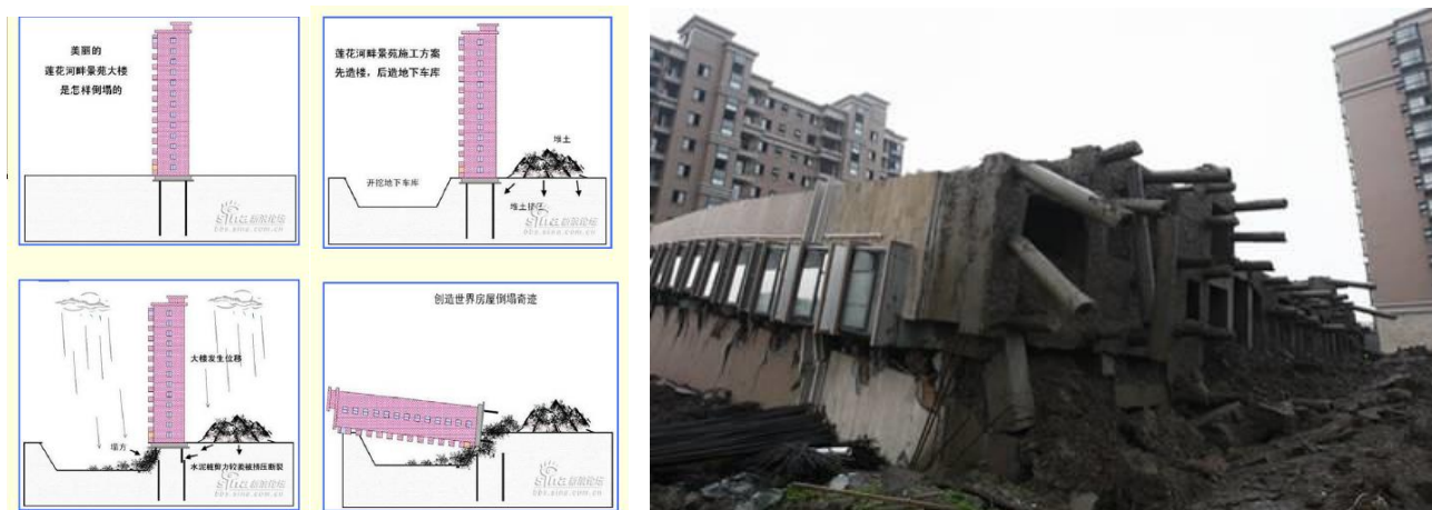
Figura 8: Caída de un edificio en Shanghai. China
