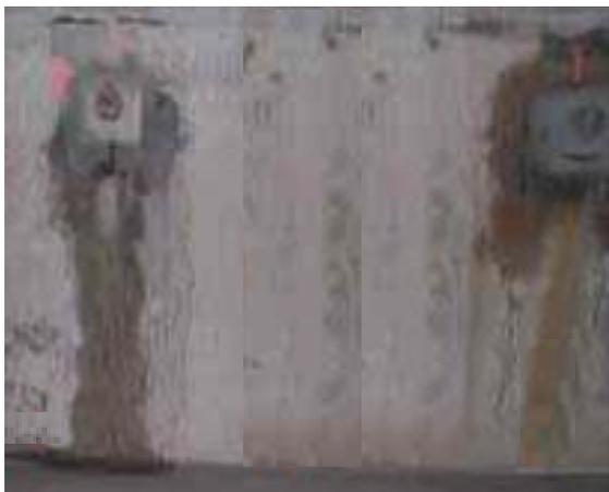
Fig. 3: Filtración por el anclaje del terreno.
