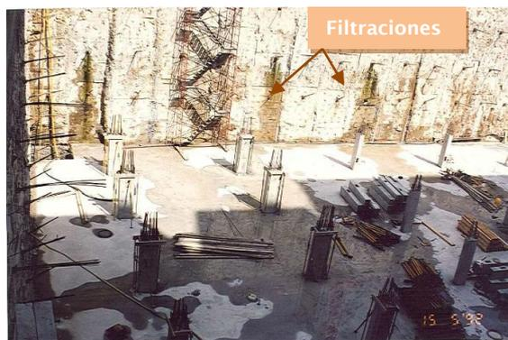
Fig. 1: Ejecución pantalla continua de H.A.
