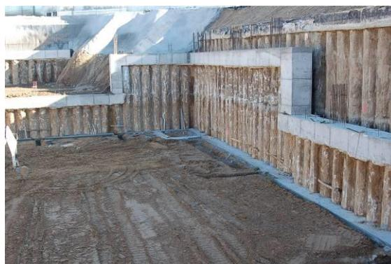
Fig. 2: Ejecución pantalla de pilotes
