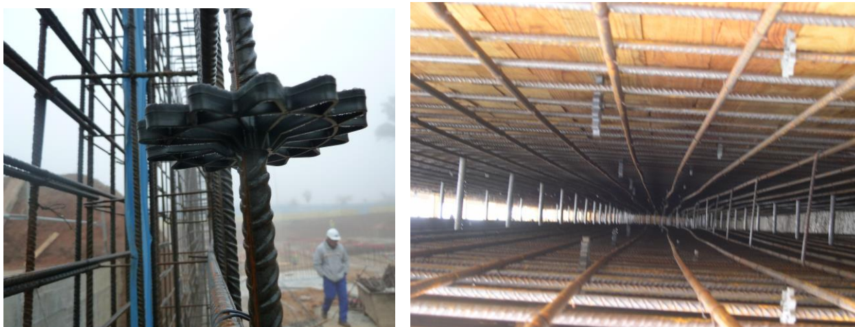
Figura 11. Colocación separadores en el armado del muro
