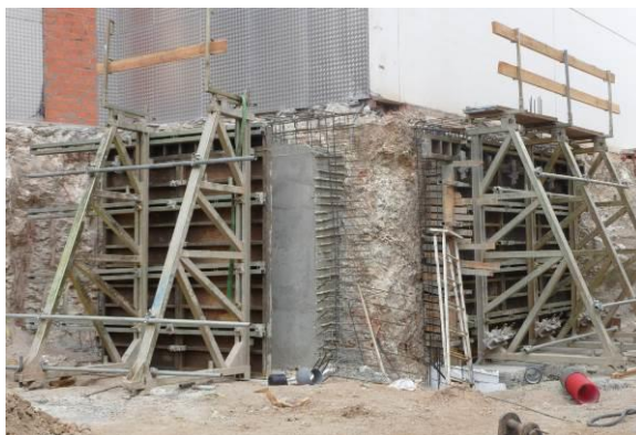
Fig. 2: Ejecución muro por bataches
