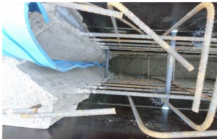
Figura 12. Junta de hormigonado y retracción
