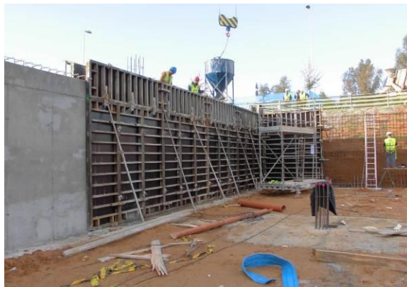
Fig. 1: Ejecución muro contención
