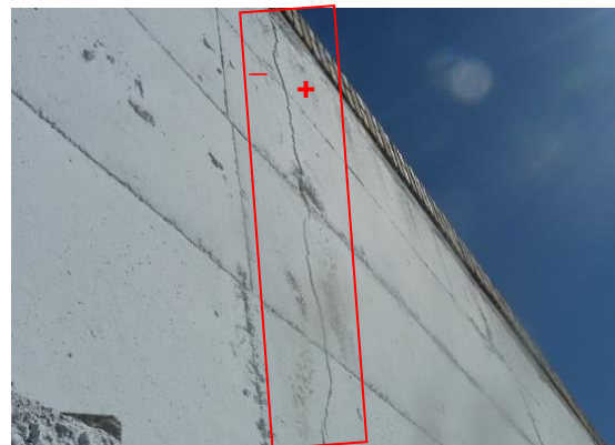
Figura 7. Desprendimiento por corrosión de armaduras
