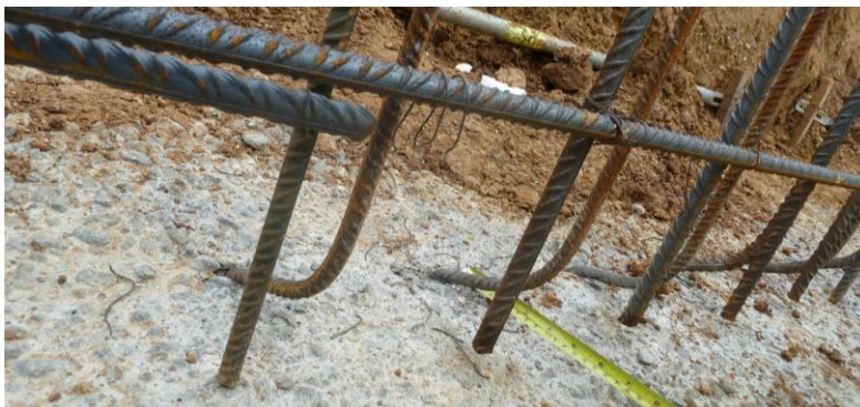
Figura 10. Grifado de las armaduras en espera del muro
