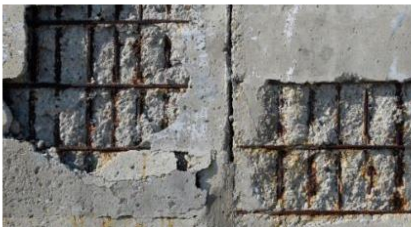
Figura 7. Desprendimiento del recubrimiento de hormigón por corrosión de las armaduras
