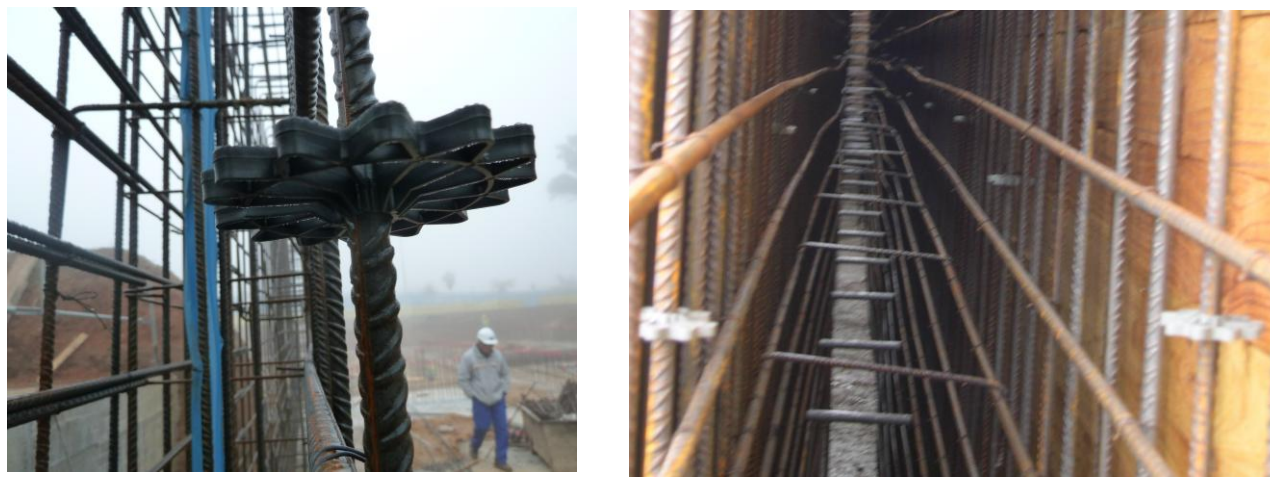
Figura 11. Colocación separadores en el armado del muro
