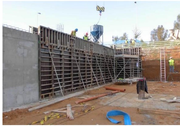
Fig. 1: Ejecución muro contención
