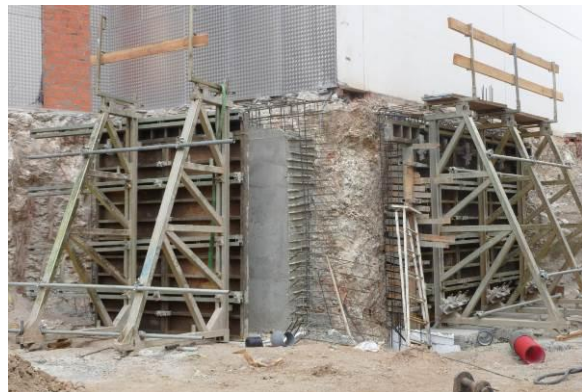
Fig. 2: Ejecución muro por bataches
