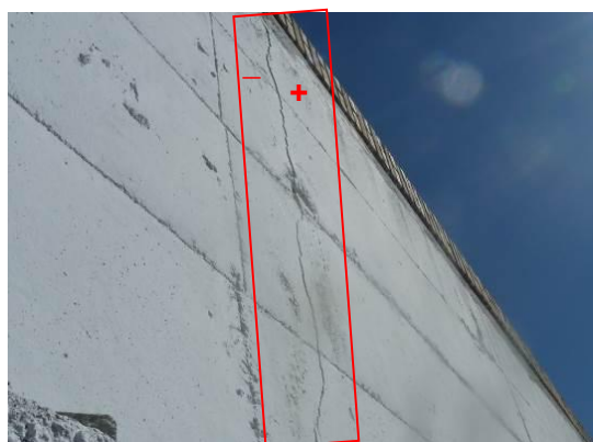
Figura 7. Desprendimiento del recubrimiento de hormigón por corrosión de las armaduras
