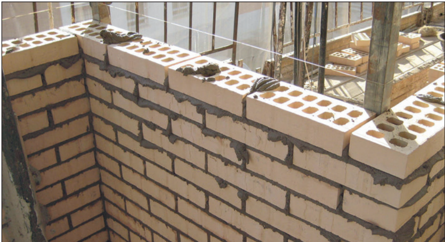
-Imagen F- Disposición de miras en cada cambio de sentido de la fábrica (esquinas y rincones).
