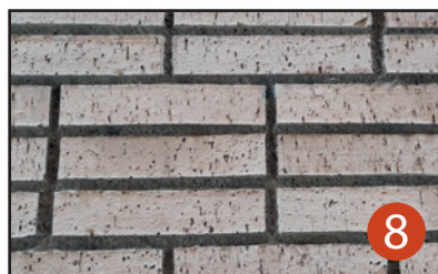
-Imagen D- Distintos ejemplos de fachadas de ladrillo cara vista en las que conjugan colores y texturas de ladrillo diferentes, diversos tipos de rejuntado y varias formas de aparejo.
