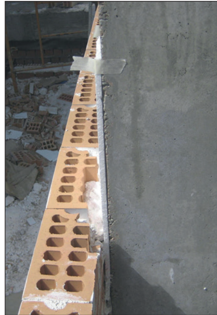
-Imagen 1- Emparchado de un pilar. A la izquierda tomando la precaución de no adherirlo por su parte posterior, y a la derecha solucionado mediante la interposición de un material elástico independizador.
