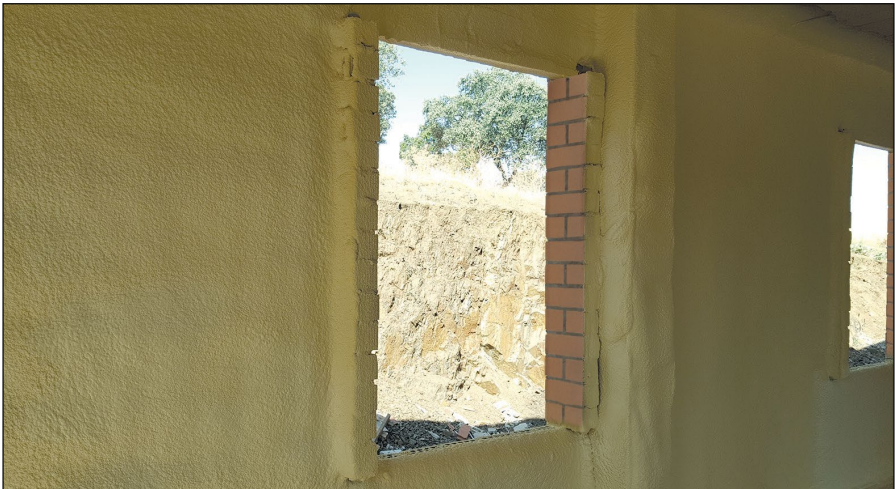
-Imagen K- Capa de aislamiento formada por una espuma de poliuretano proyectado. Se ha tenido la precaución de proyectar también la parte interna del doblado de jambas.
