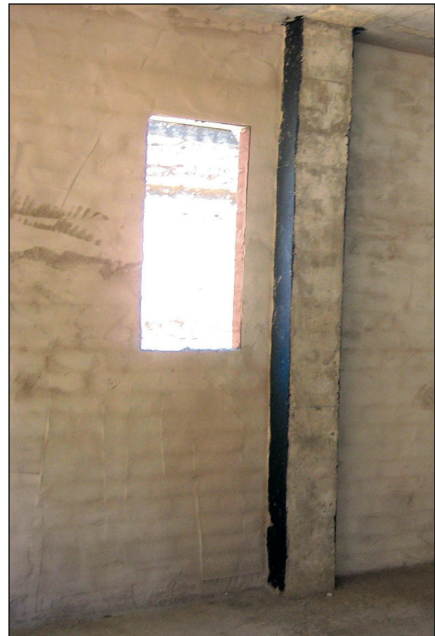
-Imagen J- Vista de dos embastados de cámara antes de aplicar el poliuretano proyectado. Se aprecia que se ha enfoscado también la parte interior del doblado de jamba (izqda.).
