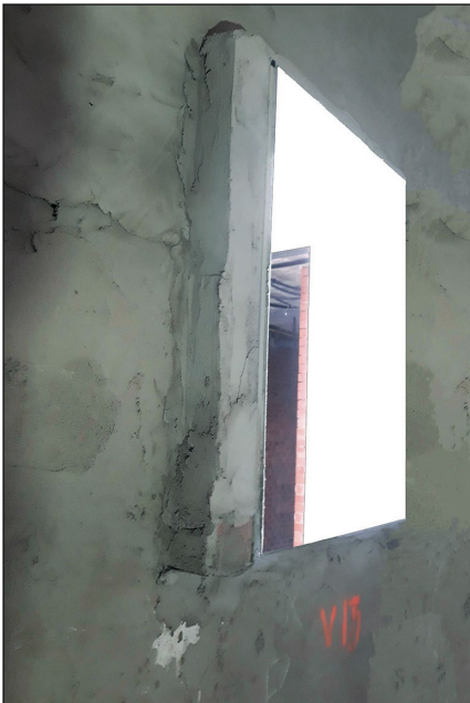
-Imagen J- Vista de dos embastados de cámara antes de aplicar el poliuretano proyectado. Se aprecia que se ha enfoscado también la parte interior del doblado de jamba (izqda.).
