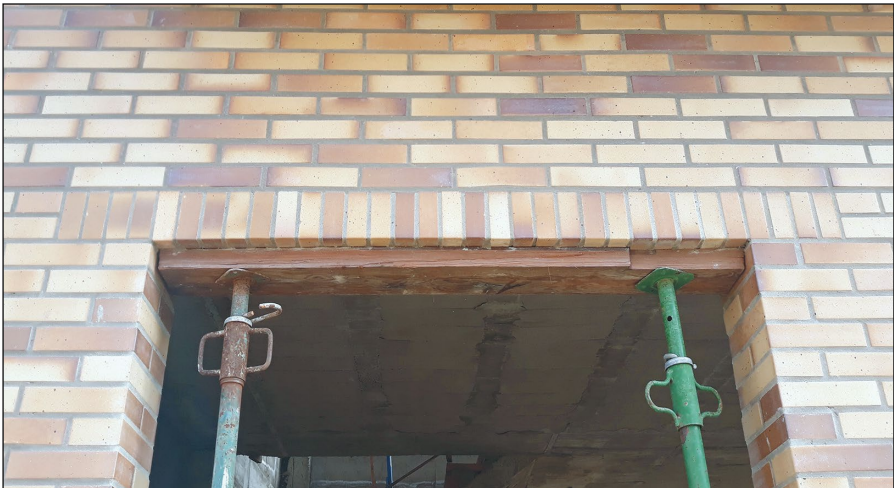
-Imagen H- Realización de un dintel armado de fábrica mediante un aparejo dispuesto a sardinel.
