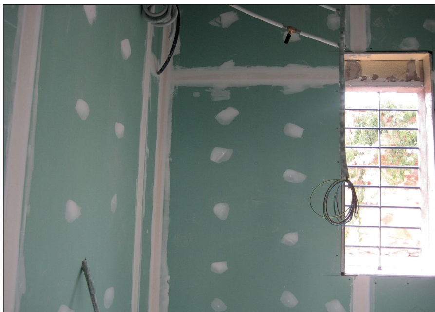
-Imagen L- Placas de yeso laminado ya colocadas en lo que será una cocina. Se procede al plastecido de las cabezas de los tornillos y a toda la longitud del encuentro de juntas.
