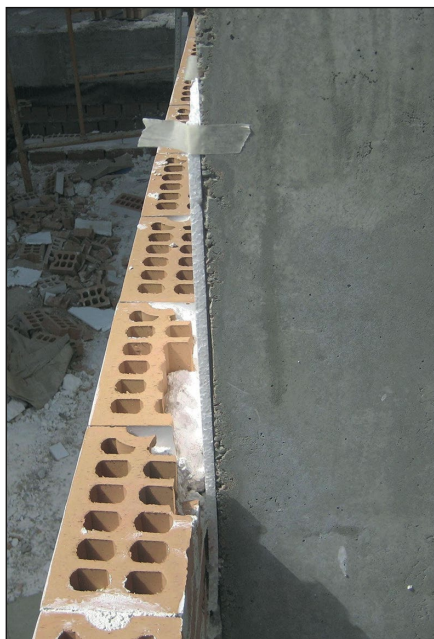
-Imagen 1- Emparchado de un pilar. A la izquierda tomando la precaución de no adherirlo por su parte posterior, y a la derecha solucionado mediante la interposición de un material elástico independizador.
