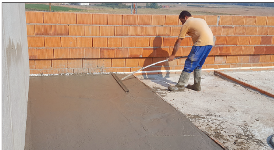
-Imagen F- Extendido y regleado de un mortero aligerado para realizar la formación de pendientes.
