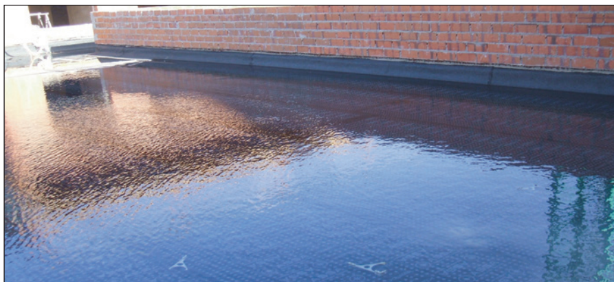
-Imagen J- Proceso de comprobación de la estanqueidad de una impermeabilización.
