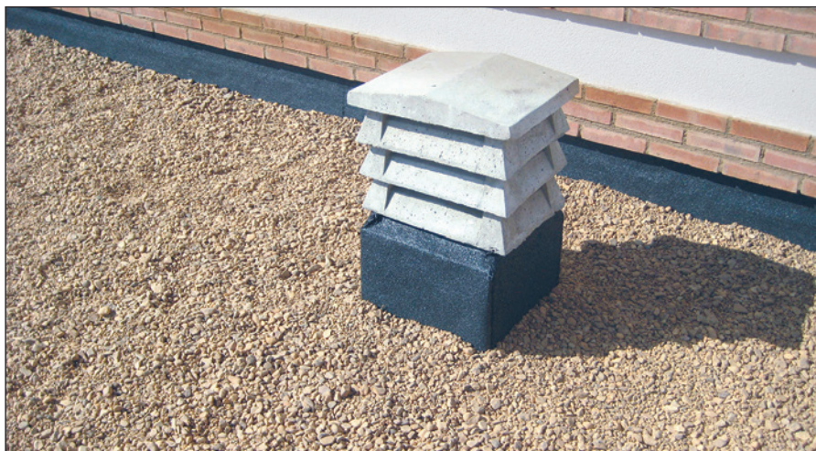
-Imagen N- Cubierta plana totalmente acabada y con la grava de río extendida superficialmente.
