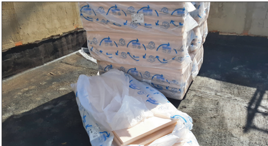
-Imagen B- Desembalaje de los paquetes con paneles de aislamiento de poliestireno extruido.
