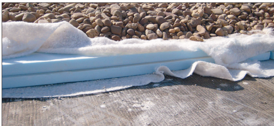
-Imagen L- Vista de la colocación de un geotextil por encima y por debajo del panel aislante de poliestireno extruido, formando respectivamente la 1ª y 2ª capa separadora.
