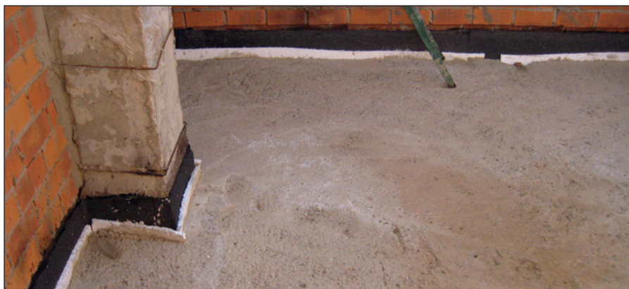
-Imagen G- Tendido de regularización de mortero de cemento ya extendido y fraguado.
