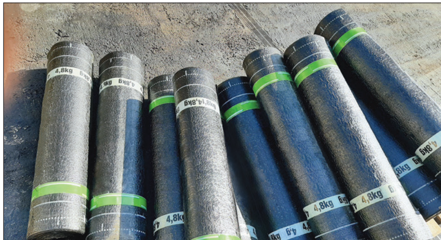
-Imagen A- Vista del acopio de distintos rollos de láminas de betún antes de su colocación.
