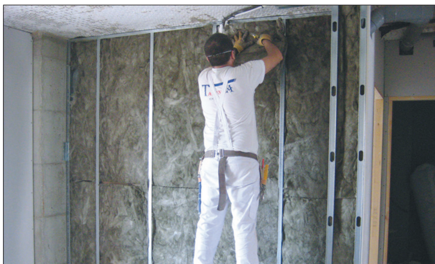
-Imagen K- Proceso de colocación y relleno de los paneles de aislamiento de lana de roca entre los huecos de los montantes.
