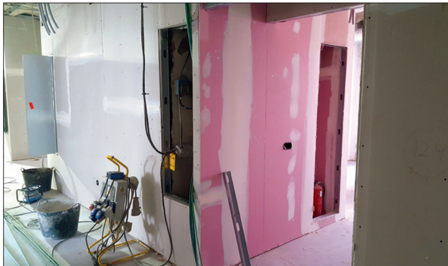
-Imagen B- Confluencia en la esquina de un tabique, en una reforma de planta hospitalaria, de una placa de tipo estándar y una placa de protección al fuego.
