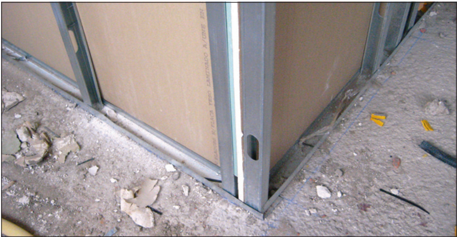
-Imagen H- Vista de la colocación de un montante de arranque y de un montaje fijo en la esquina de un tabique. Se aprecia que entre ambos deben ir las placas de una cara.
