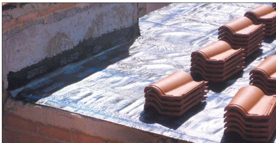
-Imagen I- Colocación de una lámina impermeabilizante en un faldón de cubierta con poca pendiente. Falta por disponer otra capa sobre dicha lámina antes de colocar las tejas.
