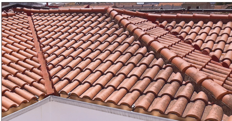
-Imagen C- Vista de una cubierta de tejas con sus limahoyas, limatesas y cumbresas.
