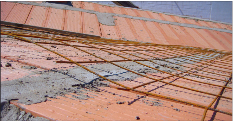
-Imagen H- Disposición de un mallazo sobre el tablero cerámico, previo al extendido de la capa de compresión.
