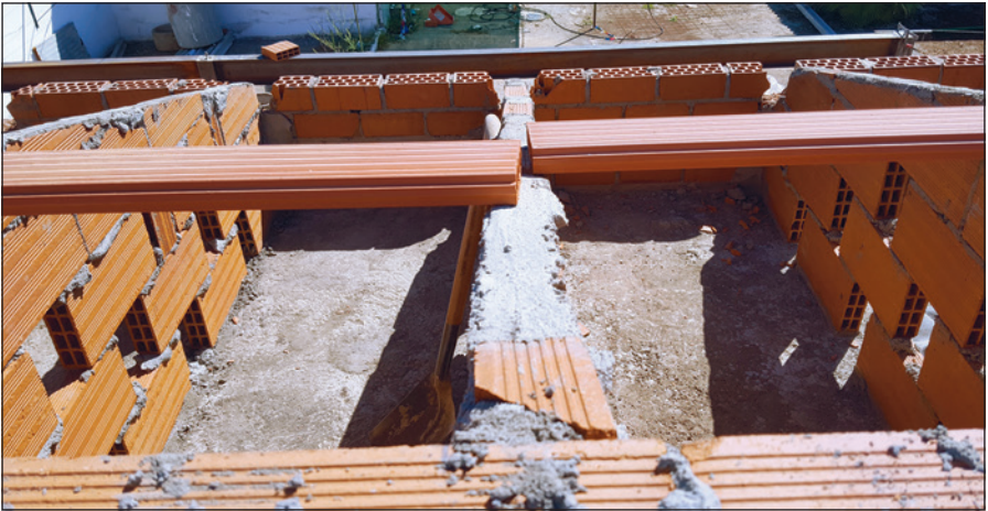
-Imagen J- Proceso de colocación de los rasillones sobre los tabiquillos aligerados.
