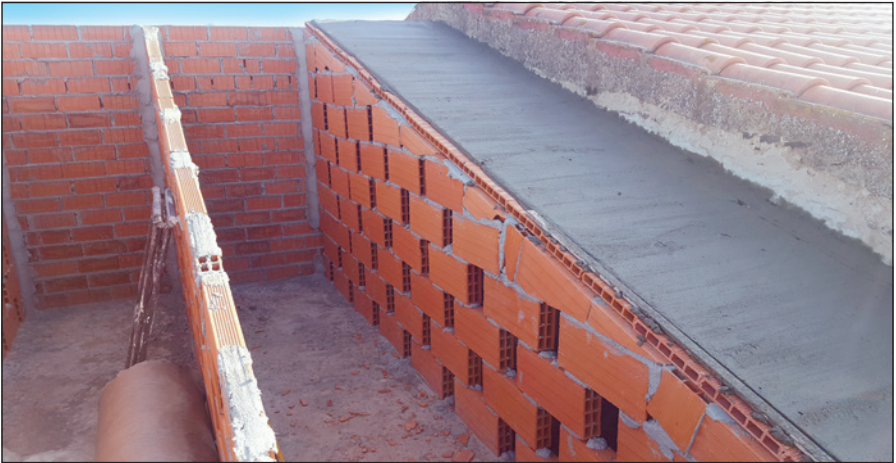
-Imagen G- Vista de la realización de la capa de compresión en una de las calles de la cubierta.
