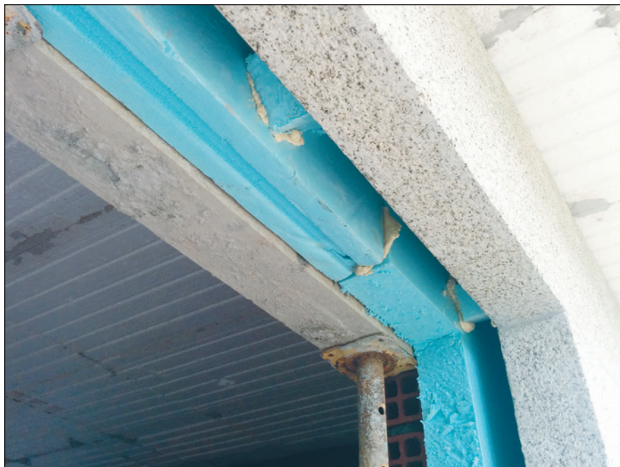
-Imagen K- Colocación de aislamiento de poliestireno extruido separado de la hoja exterior con distanciadores del mismo material (Foto: M. Rañó Rodríguez)
