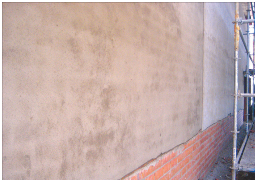
-Imagen A- Revestimiento exterior realizado con mortero de cemento
