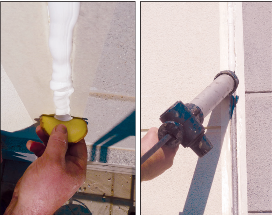
-Imagen H- Ejecución del sellado de una junta de dilatación de fachada. Aplicación del cordón y allanado superficial de este.
