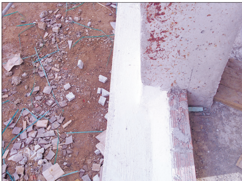
-Imagen J- Realización de una canaleta en la parte inferior de donde irá situada la cámara de aire de una fachada (Foto: M. Rañó Rodríguez)
