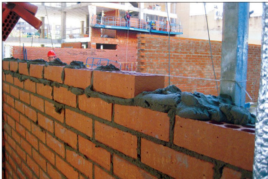
-Imagen C- Colocación de ladrillos en una hilada de la hoja exterior
