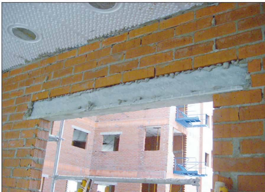
-Imagen G- Colocación de dintel en la hoja exterior de una fachada
