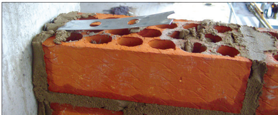
-Imagen E- Colocación de fijaciones de enganche entre la hoja exterior y los pilares. En foto superior con "armadura de amarre"; en la foto inferior con "flejes"
