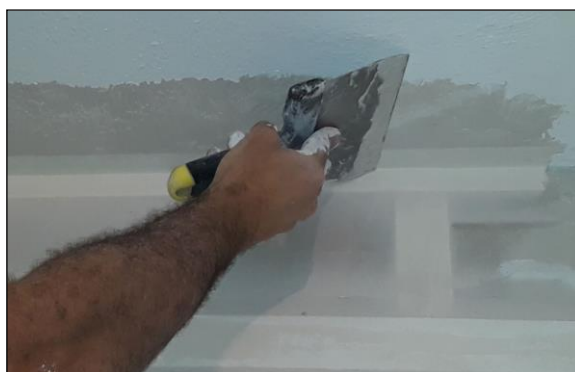
Fig. 2: Proceso de colocación y plastecido de la cinta de juntas
