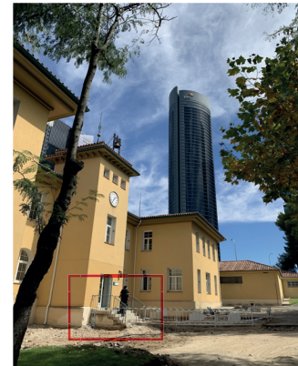
Foto 1. Acceso Zona A2. Peldaños
