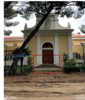
Foto 2. Acceso Zona A1. Peldaños
