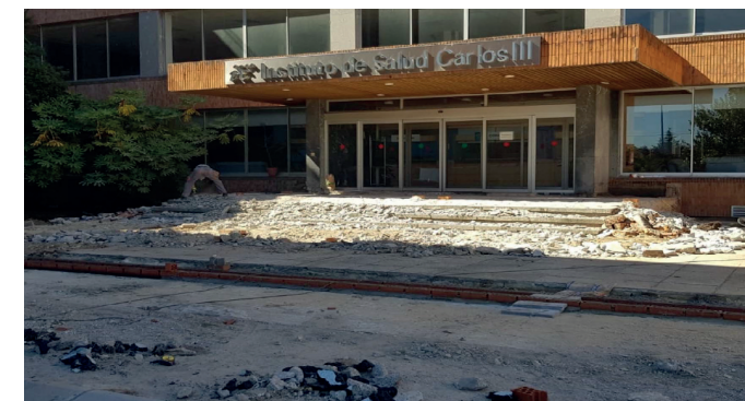
Foto 3. Demoliciones y eliminación de desniveles. Fuente: Cocirsa s.l.
