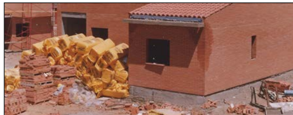
Fig. 2: Acopio de planchas de aislamiento
