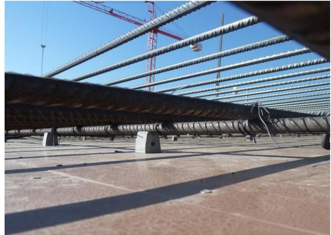
Fig. 4 Colocación separadores para garantizar el recubrimiento
