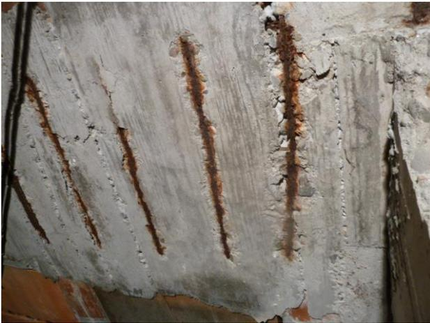
Fig. 4 Deficiente recubrimiento. Corrosión de la armadura
