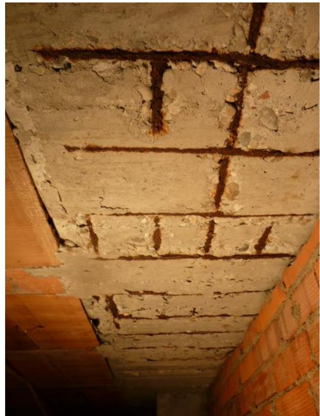
Fig. 6: Corrosión del armado de una viga pilar.
