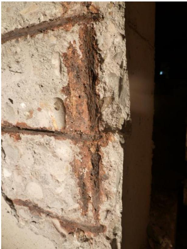
Fig. 5: Corrosión de las barras corrugadas de un pilar.
