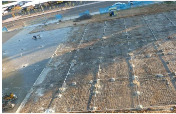
Fig. 1: Ejecución solera de hormigón
