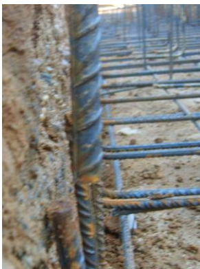
Figura 8: Inadecuado recubrimiento lateral de las armaduras con el terreno (Mínimo 7 cm).
