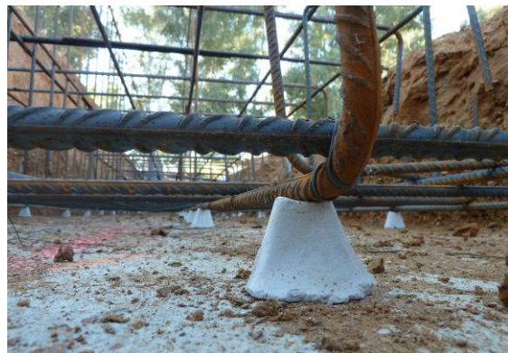
Figura 9: Recubrimiento de las armaduras. Colocación separadores
