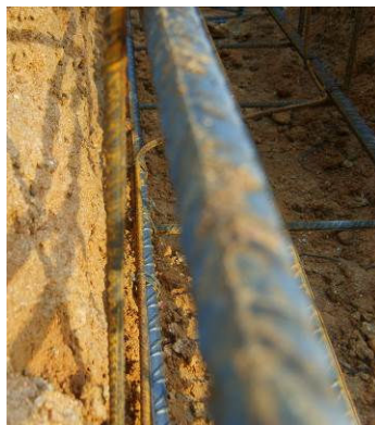
Figura 8: Inadecuado recubrimiento lateral de las armaduras con el terreno (Mínimo 7 cm).
