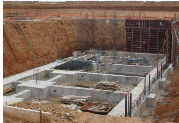
Figura 1: Ejecución de cimentación por zapatas
