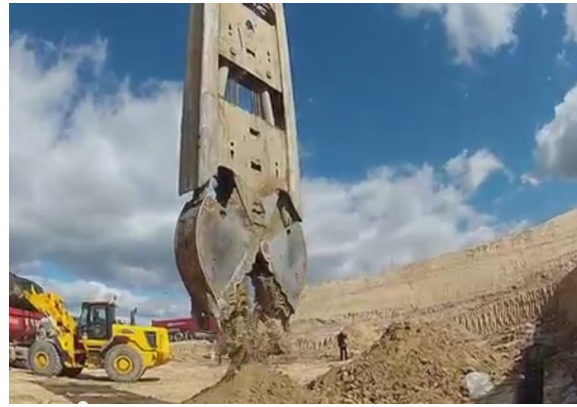
Figura 1: Excavación zanja con cuchara bivalva
