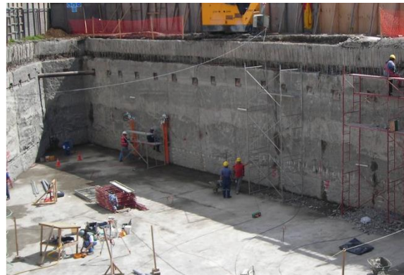
Figura 2: Muros pantalla de hormigón armado
