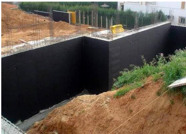
Fig. 5: Imprimación trasdós del muro
