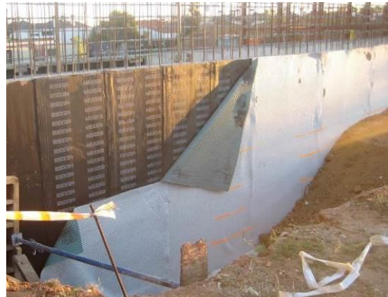
Fig. 6: Montaje lámina impermeabilizante + capa protectora
