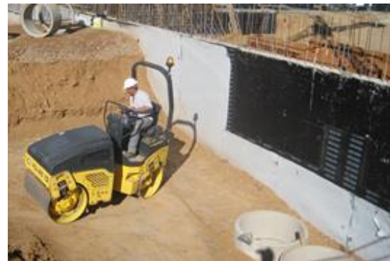
Fig. 2: Impermeabilización-capa drenante-compactación
